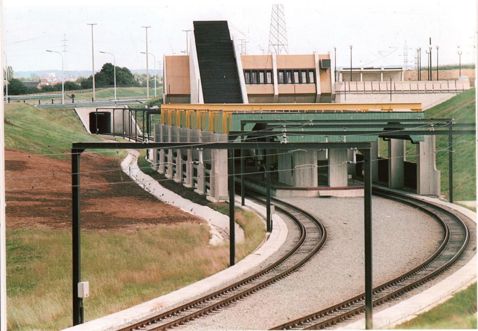
Le métro léger de Charleroi : la station LEERNES mise en service le 15 juin 1982.
