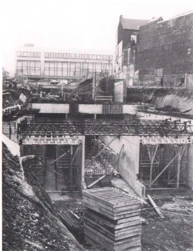
Les travaux de la station « Gilly » construite sous l'administration communale de Gilly.
