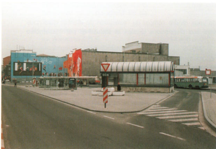
Station « Beaux-Arts » — Les échanges entre le métro léger et les autobus sont facilités au maximum. (Photo P.T.U. - Bruxelles)
