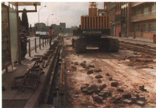
Quai Saint-Léonard - Réfection du site propre
