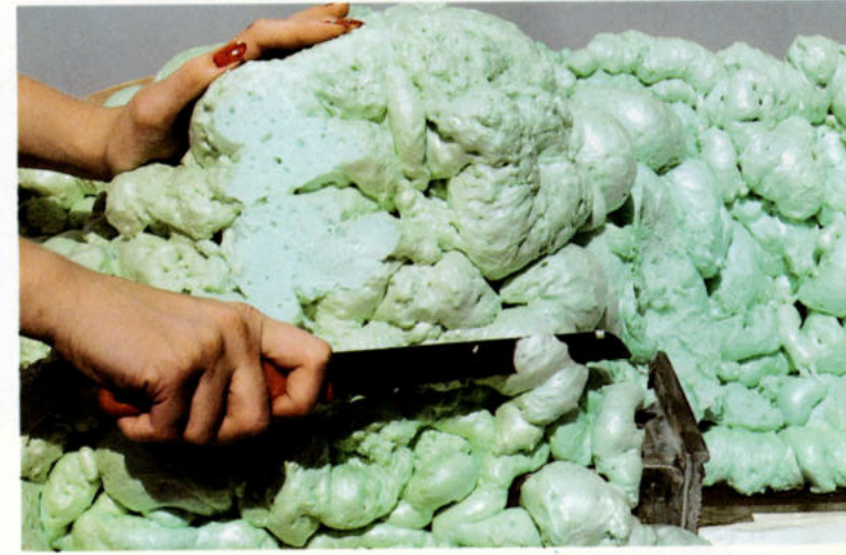
9. Nu kan het inmiddels gedroogde schuim met een scherp mes of een zaagje bewerkt worden.
