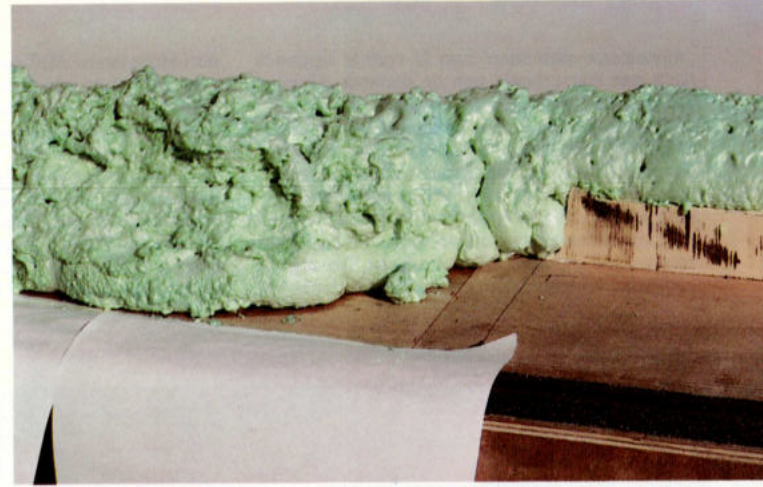
7. Het aangebrachte schuim zet nog uit en is pas na 24 uur droog.
