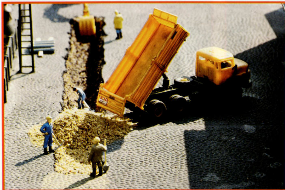
14. Terwijl op de voorgrond de sleuf al weer wordt gedicht, gaan de graafwerkzaamheden door. Alle foto's: T. Mauer
