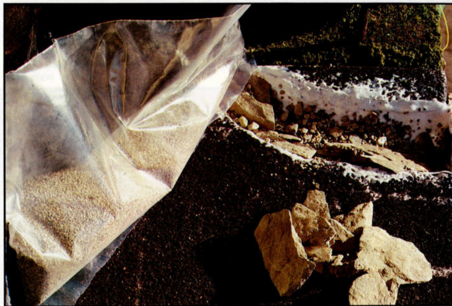
5. Eerst leisteen of rotsblokken in de buitenbochten in de nog zachte lijm vastdrukken. Daarna fijn gezeefd zand en steentjes in de bedding strooien.
