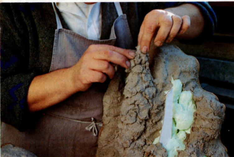
13. Met een modelleermesje worden de verticale groeven in de typische Jurastructuur aangebracht. Foto : L. Faway
