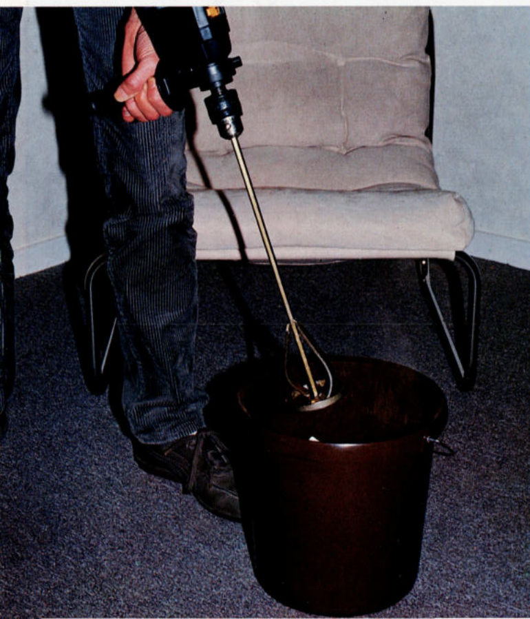
3. Het ingeweekte materiaal wordt, met een vermenger op de boormachine, stevig geroerd. Attentie : de emmer stevig tussen de benen klemmen en de boormachine op laag toerental. Foto : H.K.
