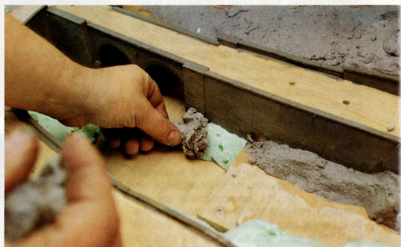
10. Zo'n stukje schuim is in de rivierbedding gelegd en wordt nu achter het papier-maché weggewerkt.
