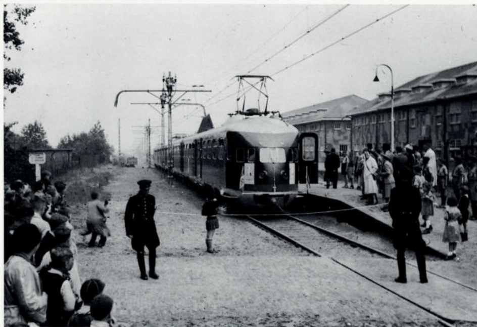
3. Nadat één spoor herlegd was, kon de dienst naar Scheveningen - Kurhaus worden hervat. Een feestelijk uitgedoste 600 wacht hier aan de Waalsdorperweg op Ir. F.Q. den Hollander, die over enkele ogenblikken het lint zal doorknippen..., 14-06-'47. Foto : J. Voerman
