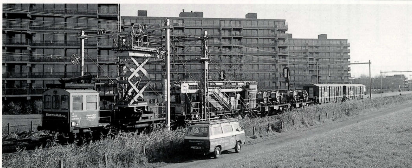
3. Vanaf de zichzelf voortbewegende voertuigen van Electrorail leggen monteurs de laatste hand aan een zogenaamd overnameveld, 03-11-'88. Foto : Harrie Peters
