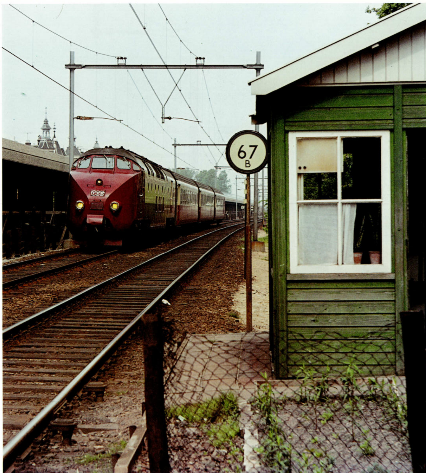
19. Een NS/SBB treinstel passeert in Delft het nieuwe spoorwegviaduct in aanbouw, april 1964.
