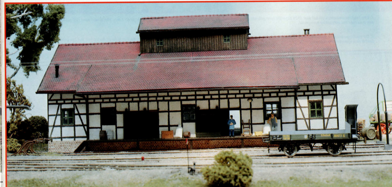
5. Het vakwerk van het gebouw van de Boerenbond is opgebouwd uit gebeitste houten profielen. Dit raamwerk werd naderhand volgegoten met een stuc samenstelling.
