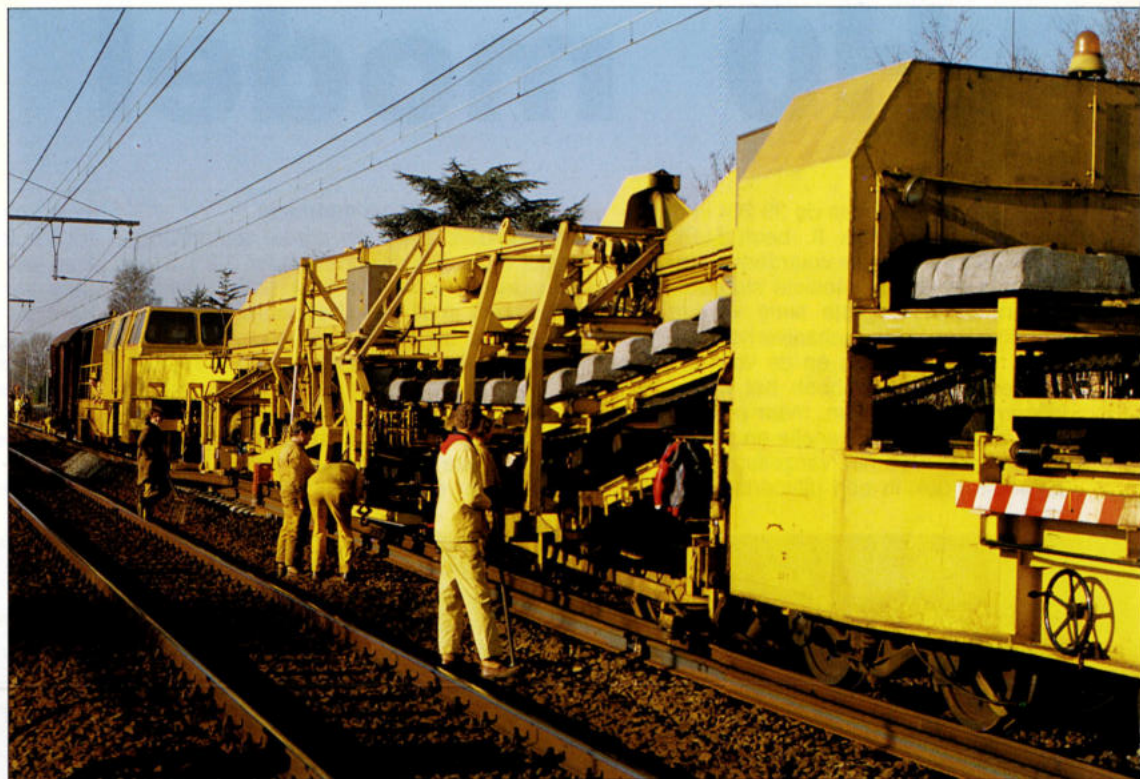
1. Een bijna volledig overzicht van het bakbeest dat P 811 Matisa heet. Al wat geel geschilderd is, vormt n geheel, en daarvan ontbreekt de motorwagen nog. De foto is in de werkricting genomen. Even samenvatten: uiterst links: de machine die de nieuwe rails op de betonnen biels plaatst; daarvoor de spoorlegger die voor de rubberonderlegplaatjes zorgt; dan de aanvoer van de betonnen dwarsliggers; en de afvoer van de houten biels. Verder komt de behandelingswagen met toevallig het portiek erop, en daarvoor nog de platte wagens. Je merkt hier ook duidelijk hoe de oude sporen zonder problemen door nieuwe vervangen worden.
