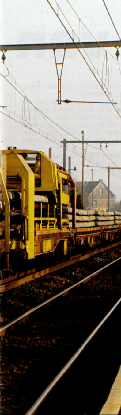
1. Een bijna volledig overzicht van het bakbeest dat P 811 Matisa heet. Al wat geel geschilderd is, vormt n geheel, en daarvan ontbreekt de motorwagen nog. De foto is in de werkricting genomen. Even samenvatten: uiterst links: de machine die de nieuwe rails op de betonnen biels plaatst; daarvoor de spoorlegger die voor de rubberonderlegplaatjes zorgt; dan de aanvoer van de betonnen dwarsliggers; en de afvoer van de houten biels. Verder komt de behandelingswagen met toevallig het portiek erop, en daarvoor nog de platte wagens. Je merkt hier ook duidelijk hoe de oude sporen zonder problemen door nieuwe vervangen worden.
