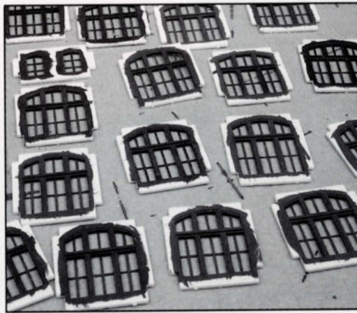
7. In plaats van het kruishout zijn nieuwe kruislatten aangebracht, drie in de lengte en één in de breedte.
