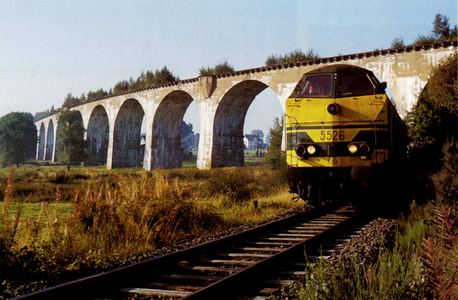
1. Het imposante viaduct van Born is een van de meest fascinerende kunstwerken van alle lijnen die tijdens de eerste wereldoorlog werden aangelegd. Zonder noemenswaardige schade werd de turbulente periode '40 - '45 overleefd, en zo maakt dit viaduct nog steeds, zij het "spoorloos", deel uit van een van de meest karakteristieke stukken van de historische Vennbahn. Foto: Marc Riguelle
