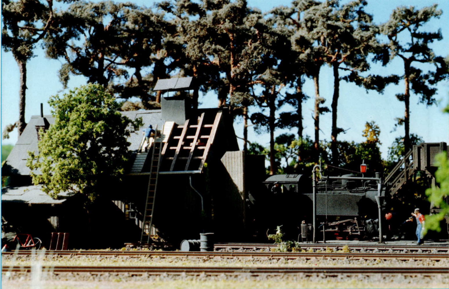
8. De lokomotiefloods is ruim voldoende geoutilleerd voor de exploitatie van het net en wordt goed onderhouden (zie het dak).
