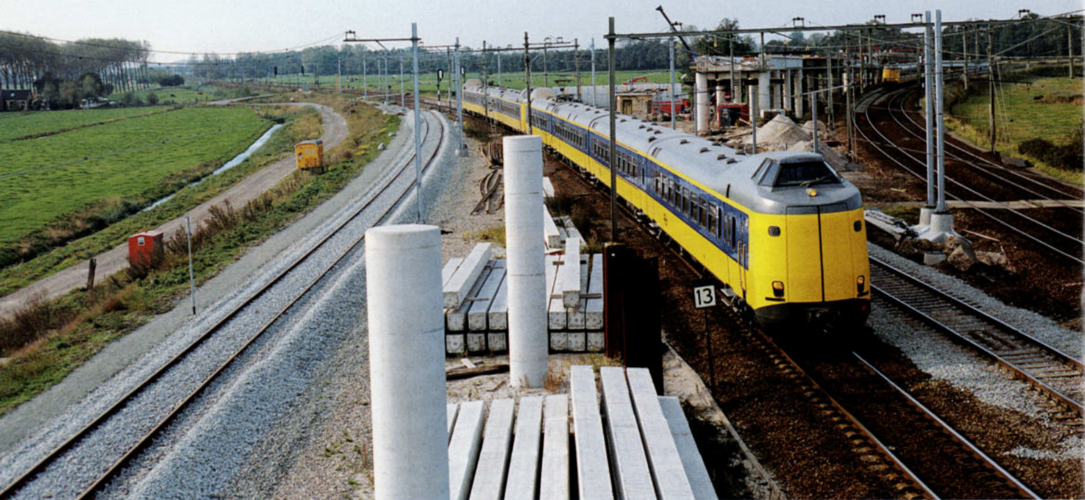
5. Op 18 november is dit plaatje al historie. Dan zal het treinverkeer van Rotterdam naar Gouda gebruik gaan maken van het linker, nog niet aangesloten spoor. Dan is de eerste fase van de omvangrijke spoorwerken bij Gouda achter de rug. Treinstellen 4209 en 4037 bij Moordrecht-aansluiting. Foto: Harrie Peters
