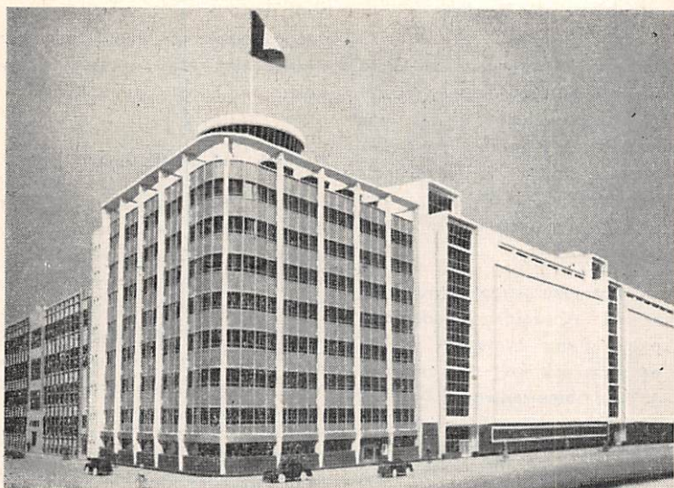
De Gevaert fabrieken. Zicht op de zo juist voltooide vleugel
