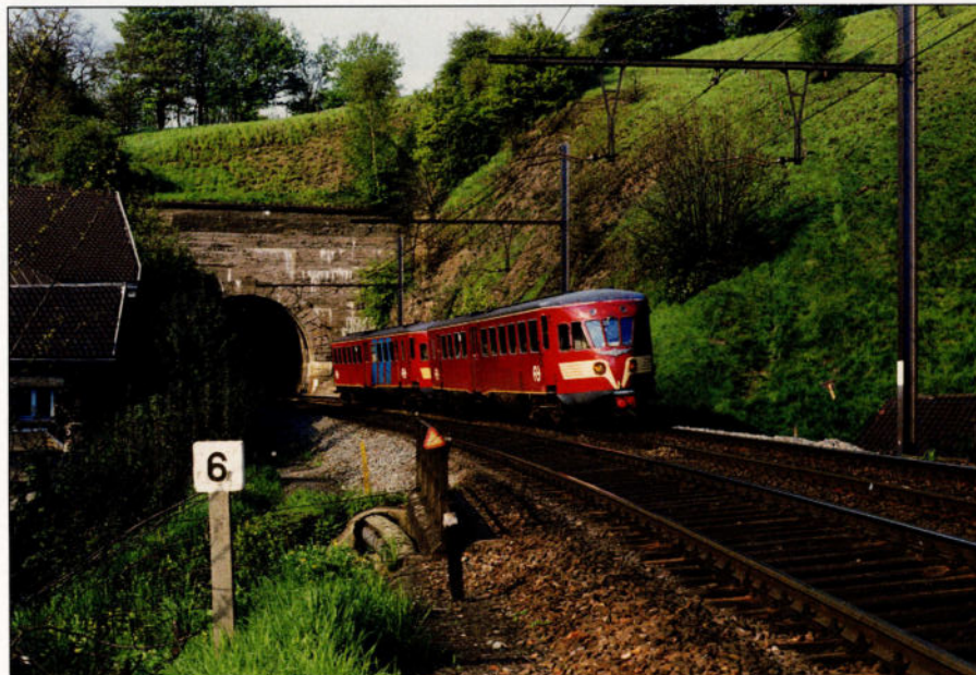
Un train Maastricht – Liège, composé de deux autorails Allan des NS, sort du tunnel de Froidmont (long de 78 m), le 7 mai 1982. Photo: Luc Ninane
