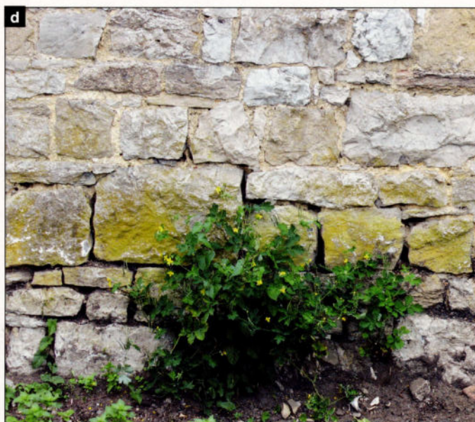
Photo d: Gros plan sur des taches orangées, apparaissant dans des zones soumises à une certaine humidité: des micro-organismes de type algues sont responsables de ces colorations.
