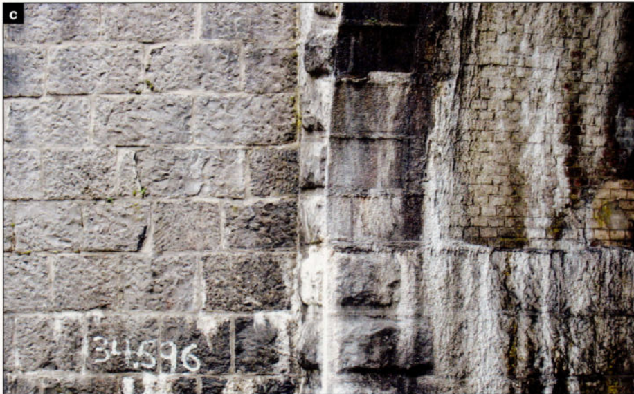
Photo c: Une vue de détail du pont sur la Malignée qui nous a servi d'inspiration. Les tailles moyennes des blocs sont imposantes: 40cm de hauteur * 70cm de largeur. Coulures et concrétions calcaires sont ici bien présentes.
