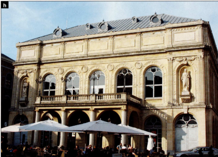
Le théâtre de Namur, d'inspiration Renaissance Italienne, est réalisé en pierre de France. Nous y notons la taille importante des éléments, la finesse des joints, et la richesse des ornements que permet cette pierre tendre. Si la façade présente une teinte relativement uniforme, nous y percevons très nettement le caractère plus terne des bandeaux horizontaux.
