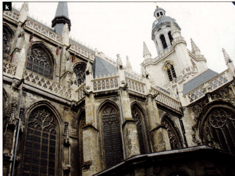
Notre Dame de Halle est une église gothique en pierre blanche. Actuellement en cours de restauration, sa nef présente encore une intense salissure terne, montrant ça et là des traces ocre rouille. La tour en revêt déjà une robe plus uniforme, ayant retrouvé la blancheur de la pierre non salie. La rehausse baroque est en pierre bleue.
