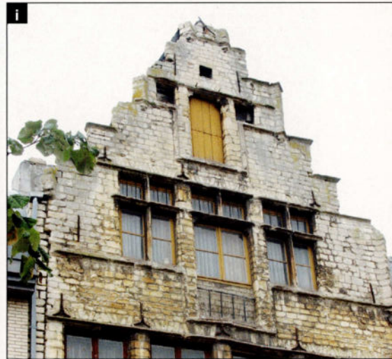
Cette maison historique malinoise montre appareillage de pierres à peine équarries, et le compliqué dessin des patines ocres.
