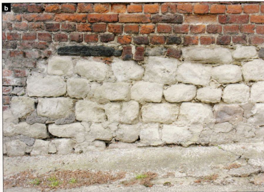
Un soubassement en pierre de sable. Ces pierres de champs de forme arrondie sont rendues légèrement rectangulaires pour constituer des moellons de construction.
