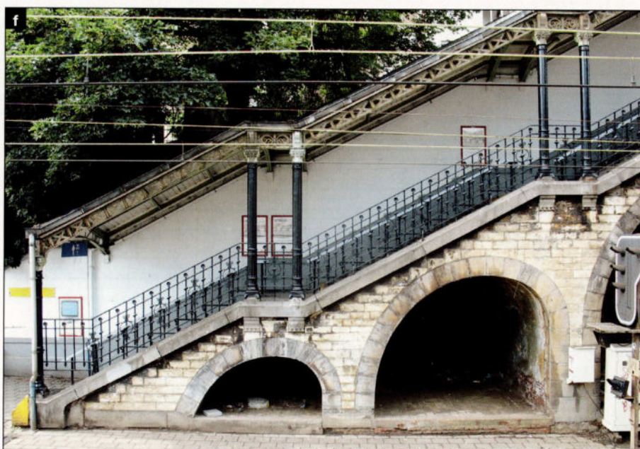
f Pierre de Gobertange et pierre bleue constituent les arcades du tunnel de la gare-pont d'Etterbeek. Chaque pierre est utilisée suivant ses qualités: couleur et finesse pour la pierre blanche, résistance et monolithisme pour la pierre bleue.
