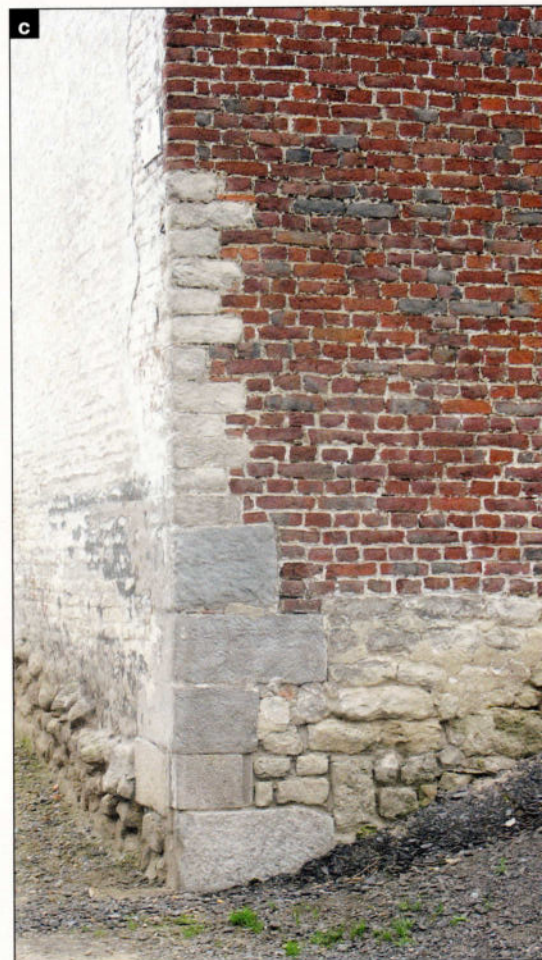
Le détail de cette ferme, dans la région de Nivelles, montre une chaîne d'angle en pierre blanche, où chaque élément correspond environ à deux assises de brique. Les cinq blocs inférieurs, en pierre bleue, sont de taille nettement plus grande. Deux soubassements faits de rognons de pierre de sable les encadrent, la partie gauche étant probablement une fondation mise à nu.
