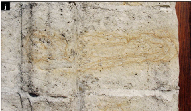
Le secret des teintes ocres de la pierre blanche est ici: le fer qu'elle contient peut resuer et rouiller en surface au fil des années, participant aux nuances orangées des murs.
