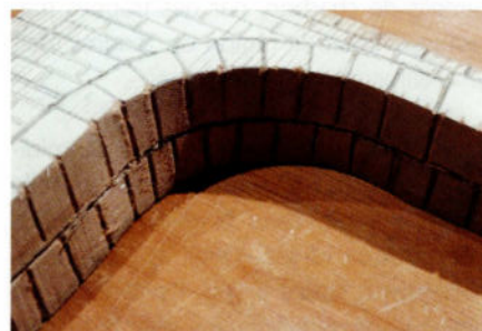
Le côté intérieur du portail de tunnel est constitué de bois de 27 mm d'épaisseur. Une structure de briques peut également y être gravée.
