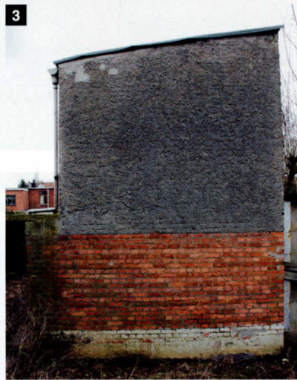
3. La face droite du box, avec enduit en ciment, les briques nues et le bord peint.
