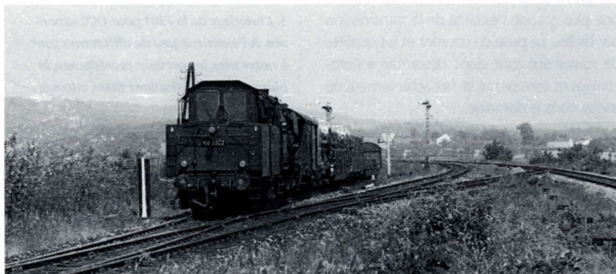
Une vue ancienne d'une BR 50 à tender-cabine en Belgique: Max Delie a photographié la BR 50.2302 (faisant partie de l'effectif du BW Aachen-West) juste avant qu'elle n'aborde le viaduc de Moresnet. On distingue à l'arrière-plan deux signaux mécaniques belges à trois positions.
