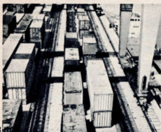
3 Terminal de Zeebrugge. Les conteneurs gerbés sur les quais de distribution montrent le gain de place réalisé dans le cadre d'un grand trafic.
