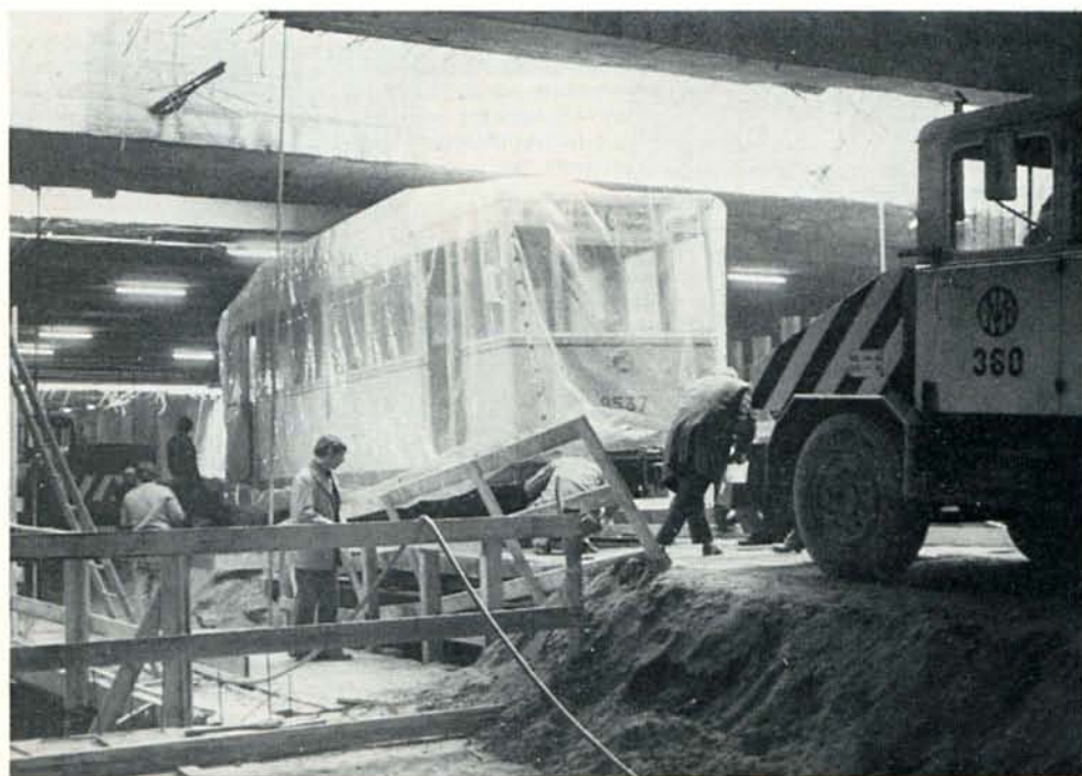
De N.M.V.B.-motorwagen 9537 wordt over de voorlopige brugkonstruktie getrokken (Foto E. Keutgens)
