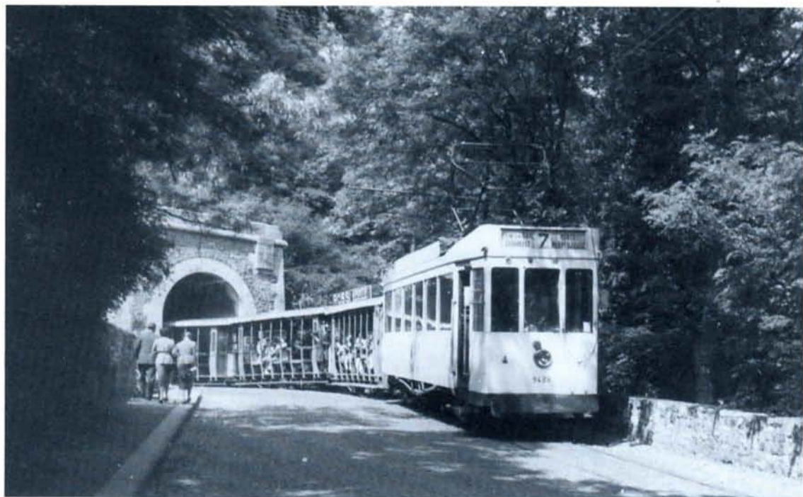
NAMUR (7 juin 1953). Motrice n° 9408 en service sur la ligne de la Citadelle après seconde transformation.
