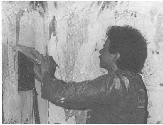
Schilder Eugene Van Damme verwijdert zomaar eventjes 4 lagen behangpapier met stoom, er voor zorgend dat de bepleistering niet mee van de muren loskomt. ←
