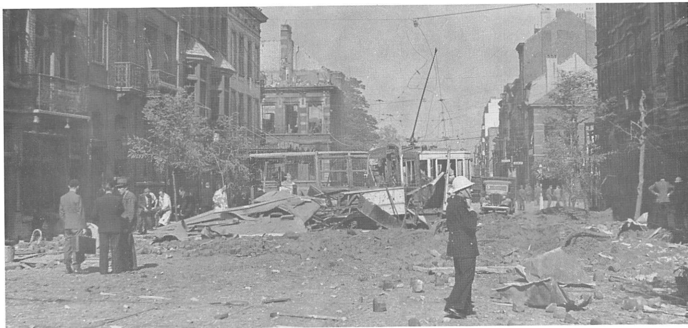
Ce qui reste du convoi formé par la motrice n° 1121 et la remorque n° 2157 après le bombardement du 7 septembre 1943 au carrefour de l'avenue de la Couronne et du boulevard Général Jacques - Photo BOURGEOIS
