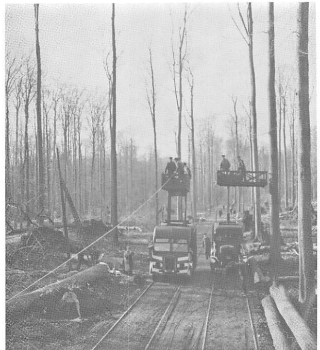
Rétablissement de la ligne aérienne après l'ouragan du 13 novembre 1940 (ligne de Tervuren en Forêt de Soignes) Photos collection E. COSAERT - PTU
