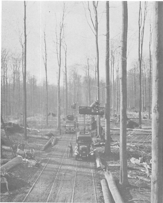
Rétablissement de la ligne aérienne après l'ouragan du 13 novembre 1940 (ligne de Tervuren en Fôret de Soignes) Photos collection E. COSAERT - PTU
