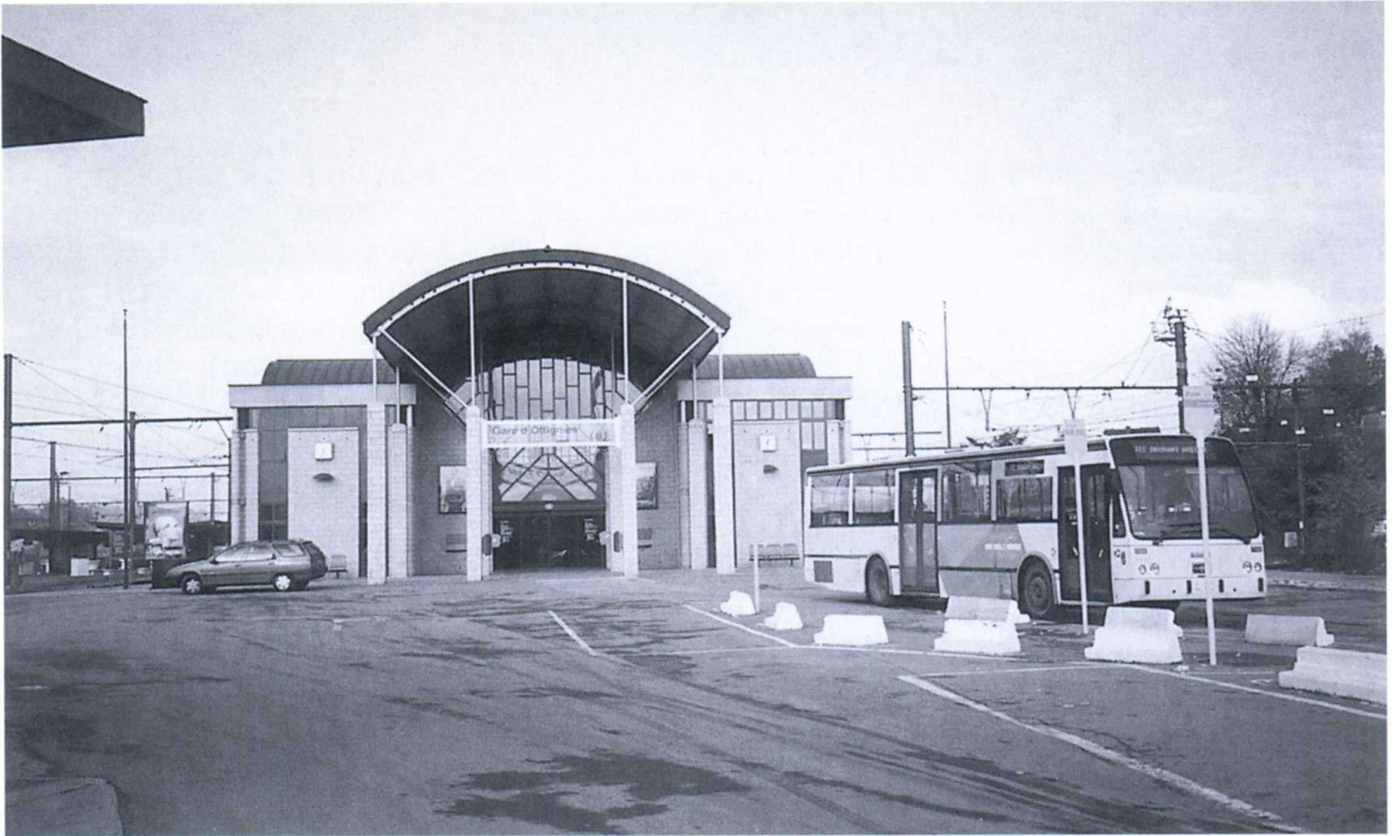
La façade de la nouvelle gare d'Ottignies en novembre 1999, en attendant le réaménagement de véritables quais pour la gare des autobus.
