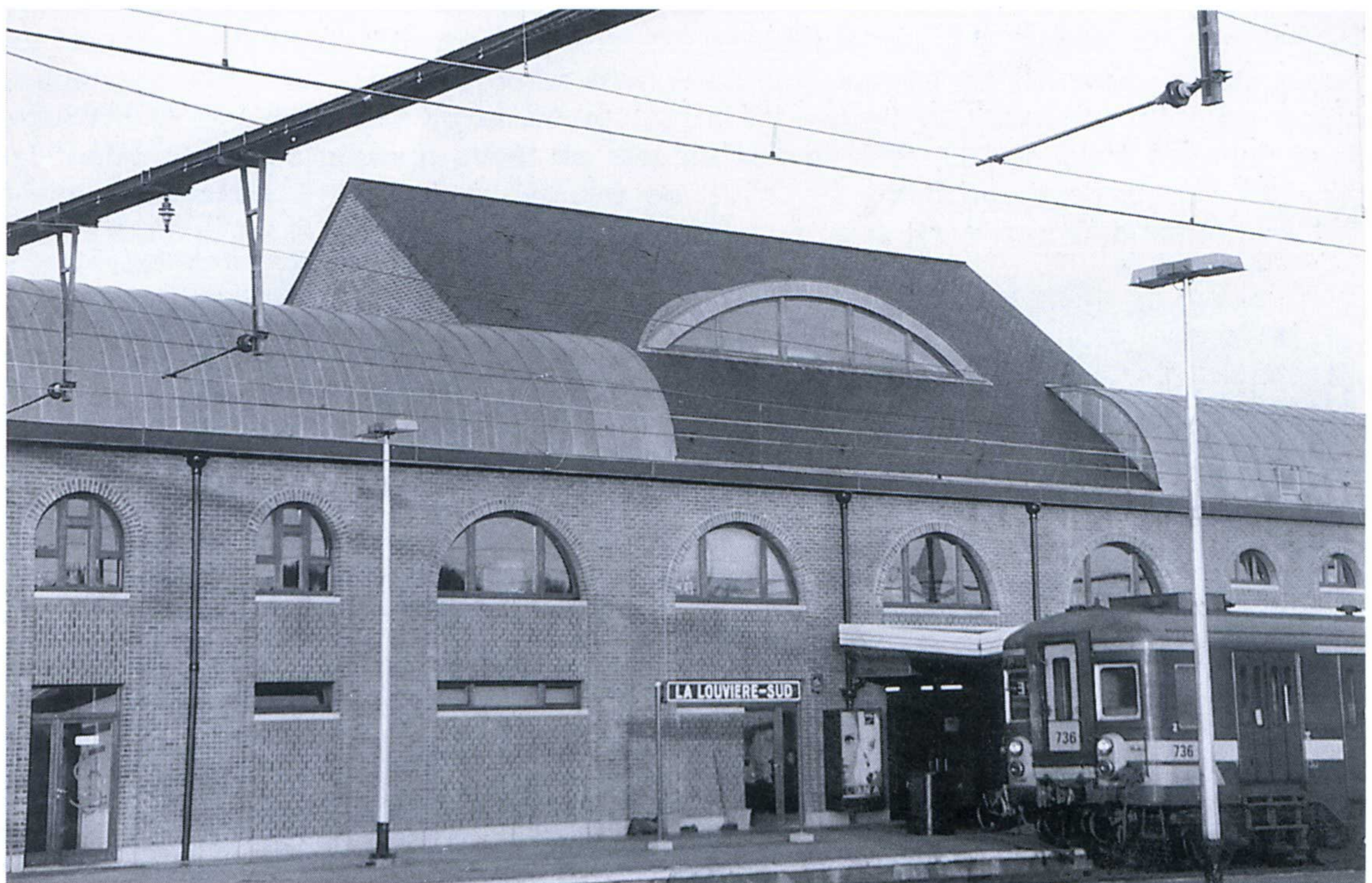
A l'été 1999, la gare de La Louvière-Sud achevée, vue côté quais.
