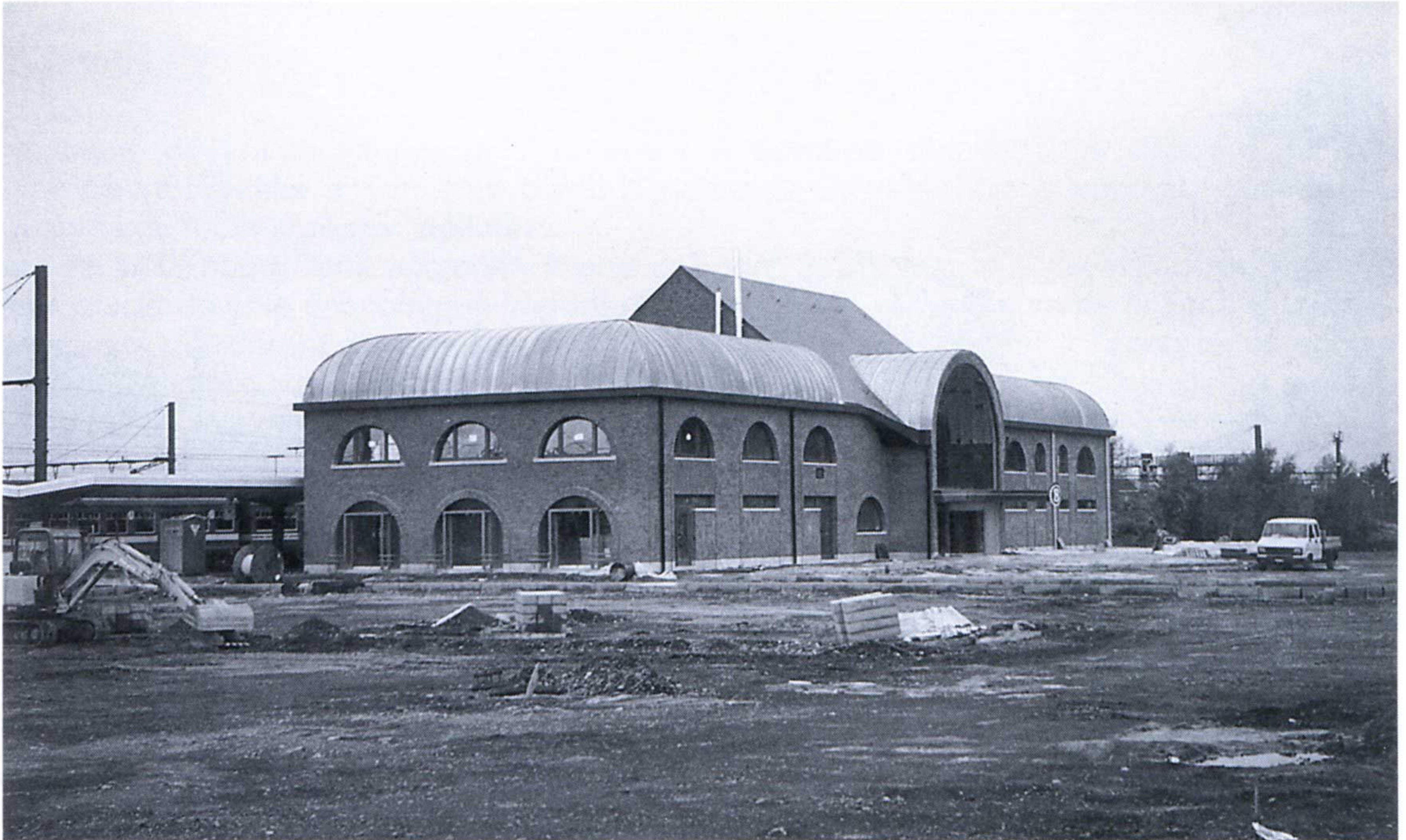
En octobre 1998, la nouvelle gare de La Louvière-Sud est en voie d'achèvement. A l'extérieur, une aire de stationnement pour autobus et un vaste parking restent à aménager.
