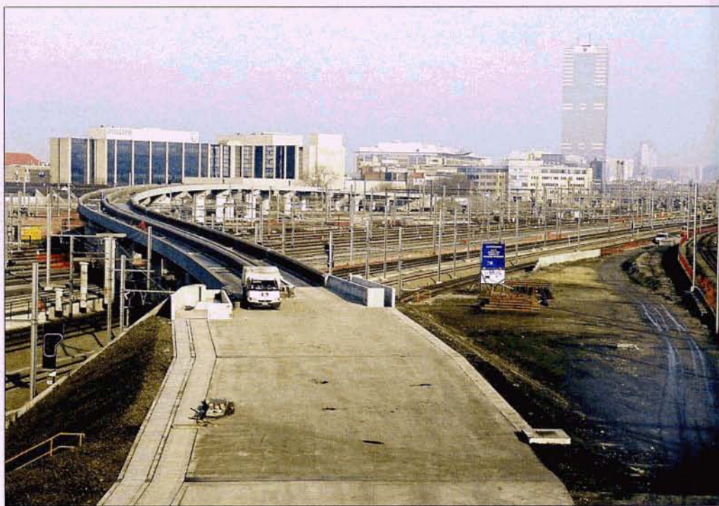
Vue générale du viaduc vers la gare du Midi. Les tabliers parallèles sont en place; il reste à poser les voies et électrifier l'ensemble, ce qui devrait être achevé en décembre 2006. Bruxelles-Midi, 10 janvier 2006. Baudouin DIEU.
