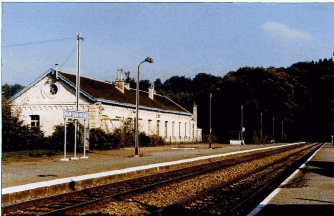
PHOTO 71-24 Victime d'un incendie le 28 novembre 2004, la gare de Ham-sur-Heure (ligne 132 Charleroi - Mariembourg - Couvin), a été démolie durant l'automne 2005. Elle n'appartenait plus à la SNCB depuis plusieurs années. Voici une vue de la gare réalisée le 25 septembre 1986. Jean-Luc VANDERHAEGEN.
