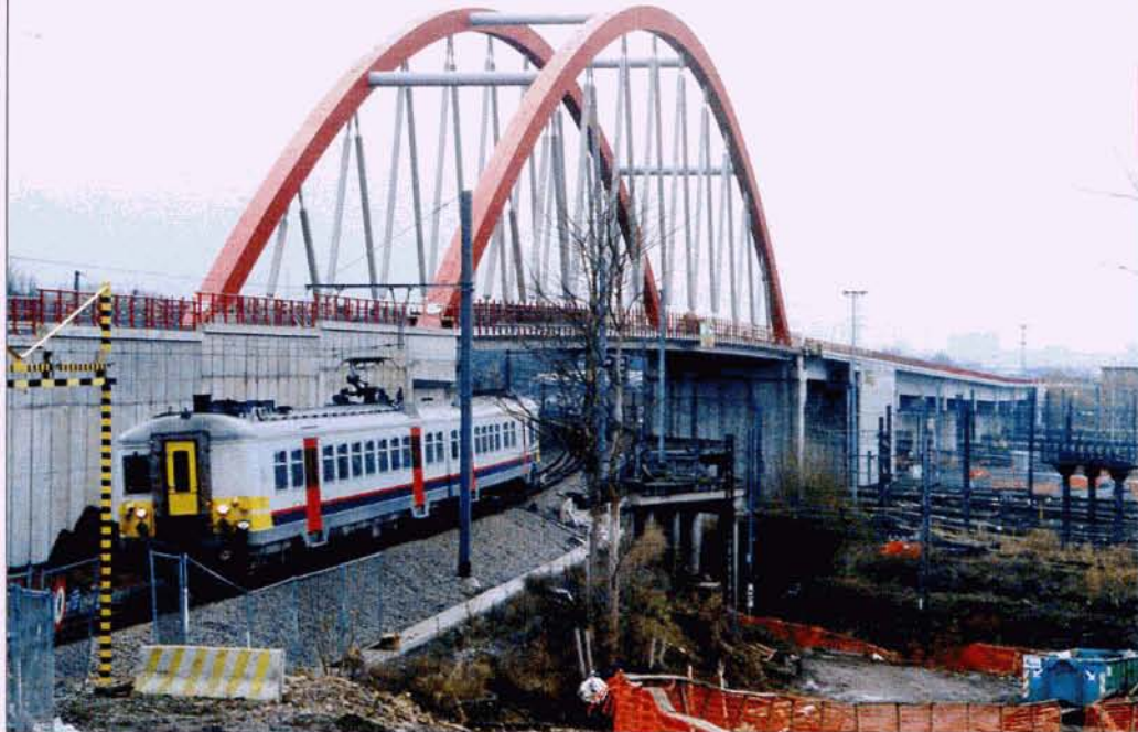
Le tablier principal du viaduc de Schaerbeek est en forme de bowstring, semblable à ceux de Halle, Leuven et Luchtbal. Il a été construit à même le viaduc avant d'être poussé à son emplacement définitif, opération réalisée durant le week-end des 29 et 30 octobre 2005. Ci-dessus : une automotrice assurant la liaison vers l'Aéroport de Bruxelles-National vient de passer au-dessus des lignes 25 et 27 et sous la future ligne 36N. Ci-dessous, passage d'un ICE vers Köln sur la ligne 36. Christian DOSOGNE, 1er janvier 2006.
