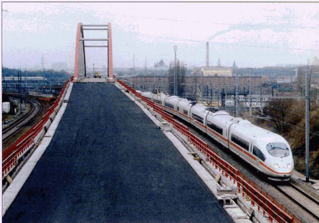
Le tablier principal du viaduc de Schaerbeek est en forme de bowstring, semblable à ceux de Halle, Leuven et Luchtbal. Il a été construit à même le viaduc avant d'être poussé à son emplacement définitif, opération réalisée durant le week-end des 29 et 30 octobre 2005. Ci-dessus : une automotrice assurant la liaison vers l'Aéroport de Bruxelles-National vient de passer au-dessus des lignes 25 et 27 et sous la future ligne 36N. Ci-dessous, passage d'un ICE vers Köln sur la ligne 36. Christian DOSOGNE, 1er janvier 2006.
