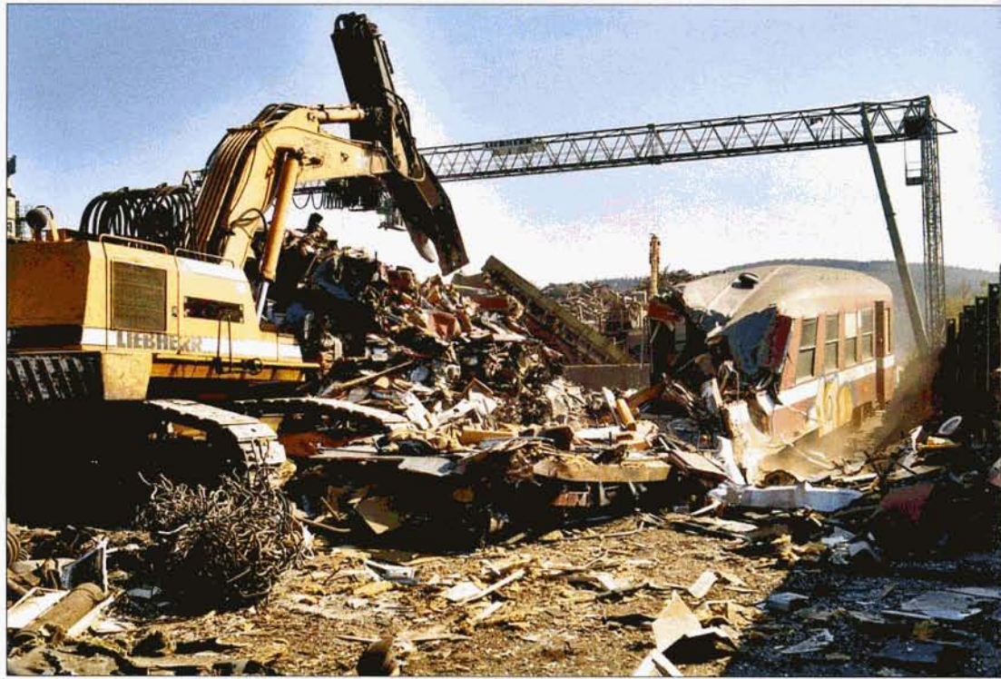
Une vue de la démolition des voitures K4 dans le chantier du ferrailleur Steil dans le port de Trier. Tomas JURGEN, avril 2007.
