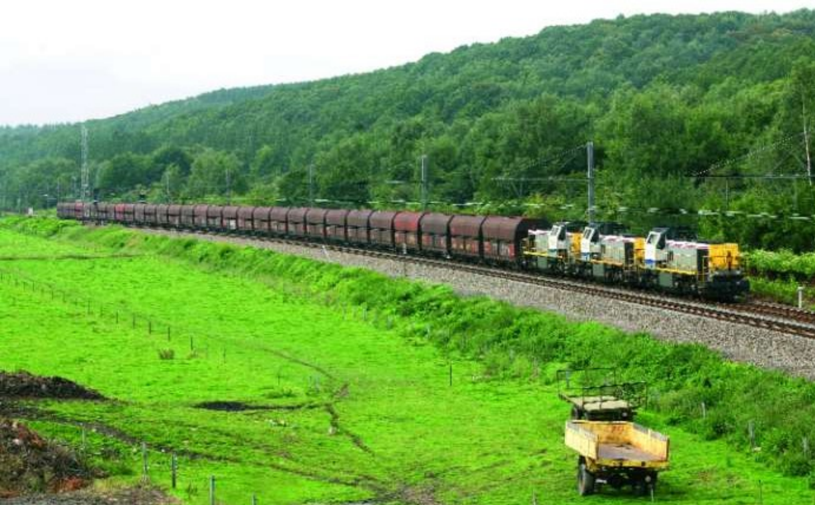
PHOTO 82-44 Le train 48555 Yves-Gomezée - Millingen circula deux fois par semaine en pleine nuit, remorqué par trois locomotives de la série 77/78. Le 5 septembre 2007, il accusait plusieurs heures de retard, ce qui permit de le photographier de jour. Il passe ici dans les environs de Java sur la ligne 125 Namur - Liège, remorqué par les 7749 + 7743 + 7737. Michel HANSENS.
