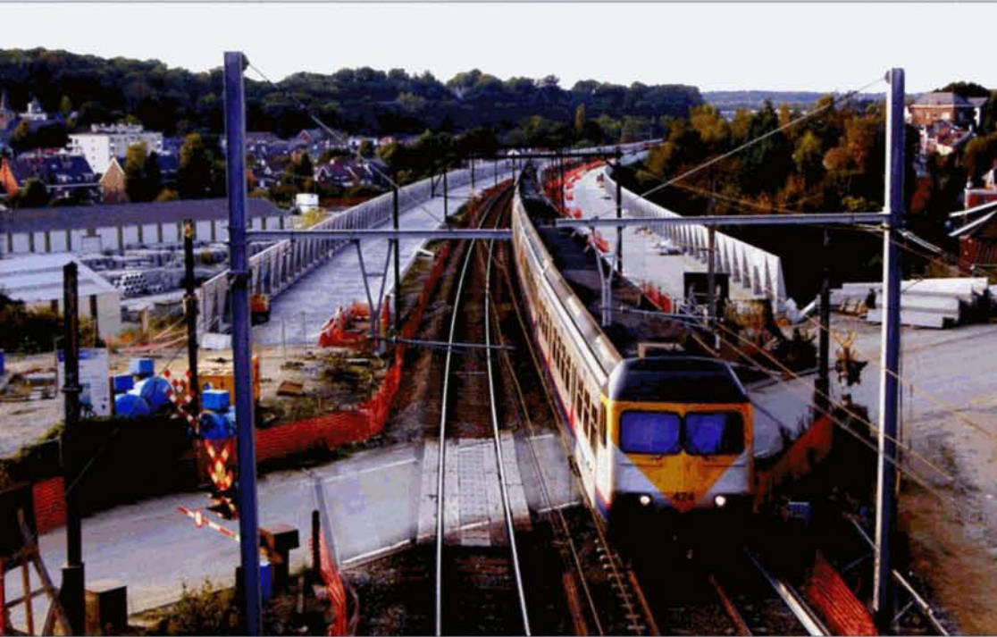
PHOTO 94-92 L'Euromotrice 90 "Vauban" Zürich - Bruxelles-Midi arrive à Ottignies. Sur ce document, on voit bien l'élargissement de l'assiette constituée en fait d'une sorte de viaduc suspendu au-dessus du terrain. De cette manière, il n'est pas nécessaire d'élargir le talus, permettant ainsi d'éviter au minimum les expropriations. Ottignies, 19 septembre 2009. Olivier JOASIN.
