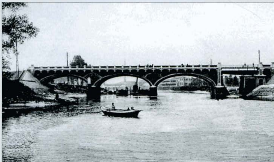
Une autre vue du troisième pont. La partie mobile est visible à droite, côté Antwerpen. A l'arrière-plan, il ne reste plus grand chose de l'ancien pont. Collection Paul JACOBS.
