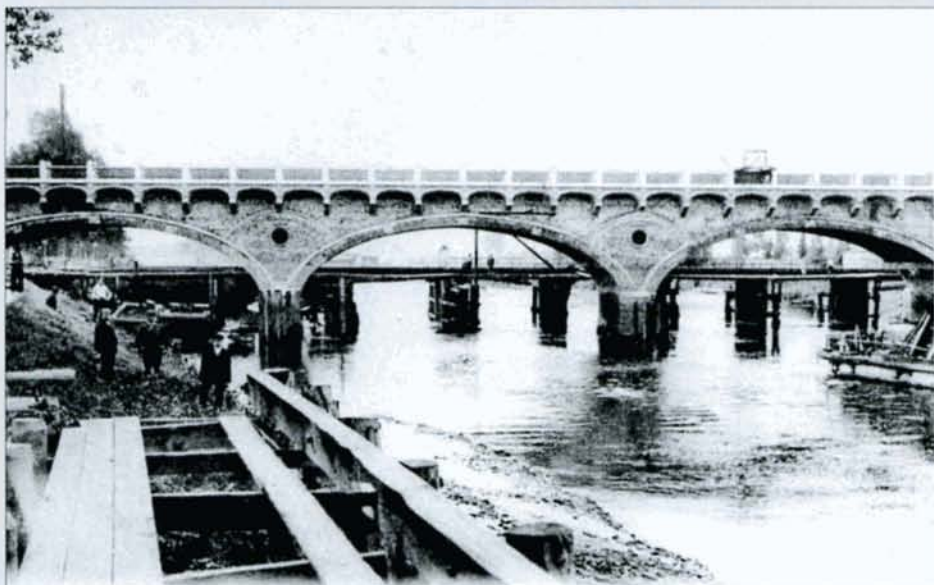
Le troisième pont composé de trois arches en pierre, vu vers 1905, lors de sa mise en service. L'ancien ouvrage est visible à l'arrière. Collection Paul PASTIELS.
