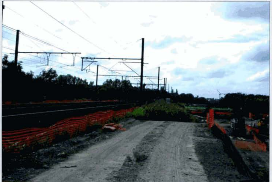
Une vue des travaux prise en direction de Bruxelles. Les deux premières voies à gauche sont celles de la ligne 25. Paul JACOBS, 12 septembre 2009.
