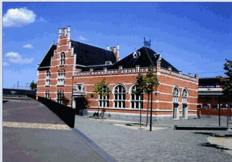
La gare d'Antwerpen-Dam photographiée en 1907. La même année, la bâtiment fut déplacé de quelques 36 m vers le sud et surélevé de 1,6 m. Ces travaux furent justifiés pour permettre de surélever les voies de façon à supprimer les passages à niveau. La construction d'une nouvelle gare était jugée trop onéreuse. A droite, la gare aujourd'hui. Le bâtiment a été classé en 1997. A gauche, on voit le dessus du puits de sortie de la jonction nord-sud. Ghislain SMOUT.
