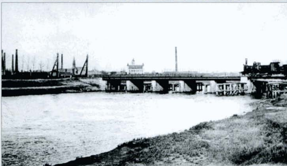
Le deuxième pont de Duffel immortalisé vers 1903. Un train remorqué par une locomotive du type 29 (0-3-0) franchit l'ouvrage. Collection Paul JACOBS.
