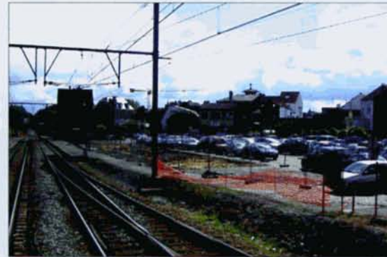
Une vue prise le lendemain de la démolition de la gare de Genval. On aperçoit au loin la gare de 1910.
