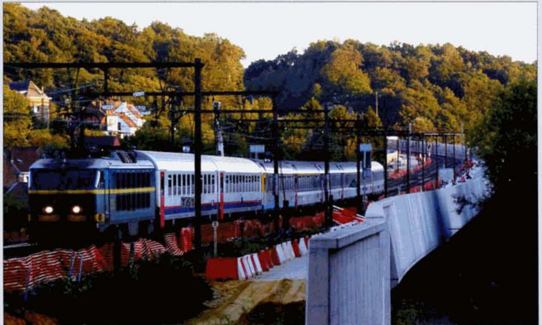
PHOTO 94-92 L'Euromotrice 90 "Vauban" Zürich - Bruxelles-Midi arrive à Ottignies. Sur ce document, on voit bien l'élargissement de l'assiette constituée en fait d'une sorte de viaduc suspendu au-dessus du terrain. De cette manière, il n'est pas nécessaire d'élargir le talus, permettant ainsi d'éviter au minimum les expropriations. Ottignies, 19 septembre 2009. Olivier JOASIN.
