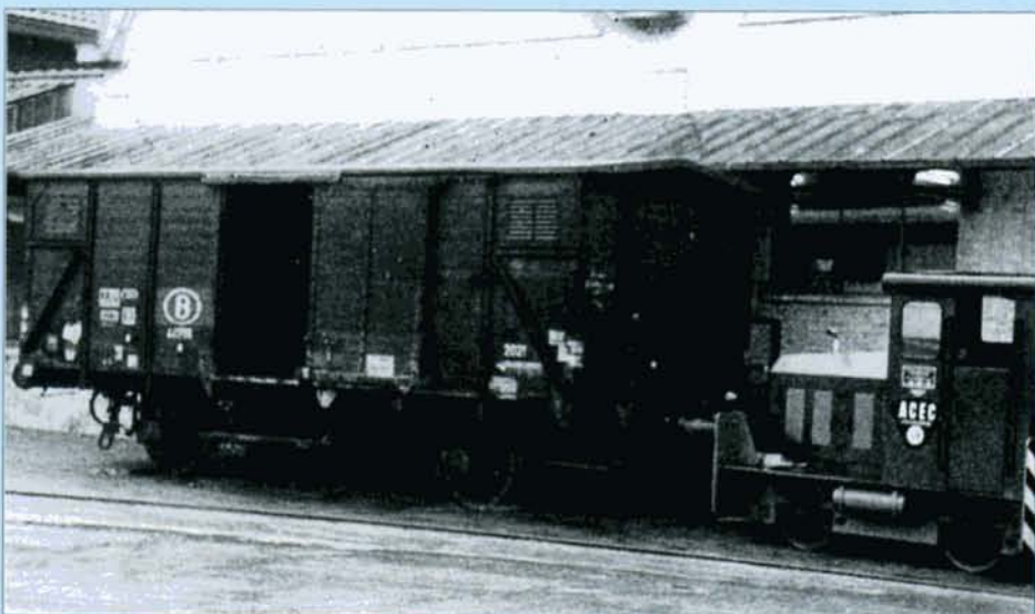
Le wagon SNCB n° 4.417.116, à guérite supprimée, ex. n° SNCB 237.339, est un de ces wagons hybrides livré à l'Etat Belge entre les deux guerres. Etant d'origine allemande, ce type de véhicule fut numéroté par l'Etat Belge dans la série 257.000 à 277.999, type 2021. Lors de leur utilisation dans le pool des wagon "EUROP" ils furent renumérotés dans la série 295.001 à 297.999 (plus tard 3.317.000 à 3.317.999 et 4.417.000 à 4.417.999). Collection Charles OCSINBERG.
