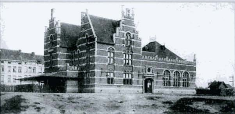
La gare d'Antwerpen-Dam photographiée en 1907. La même année, la bâtiment fut déplacé de quelques 36 m vers le sud et surélevé de 1,6 m. Ces travaux furent justifiés pour permettre de surélever les voies de façon à supprimer les passages à niveau. La construction d'une nouvelle gare était jugée trop onéreuse. A droite, la gare aujourd'hui. Le bâtiment a été classé en 1997. A gauche, on voit le dessus du puits de sortie de la jonction nord-sud. Ghislain SMOUT.
