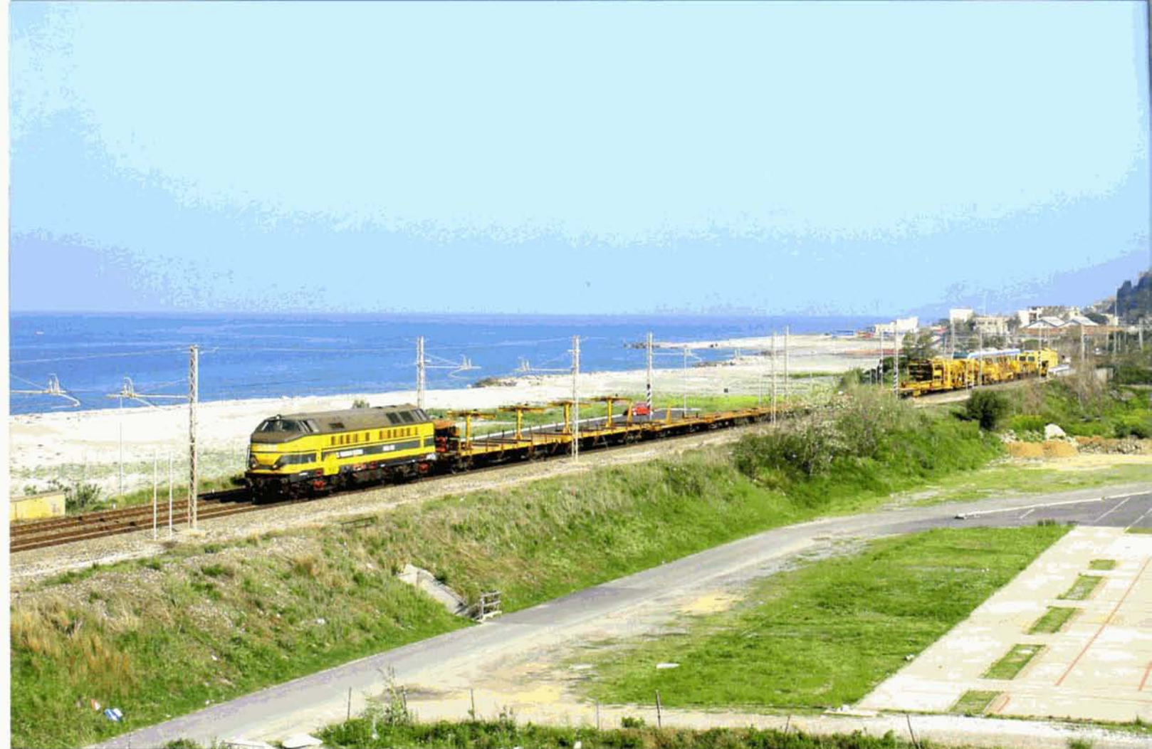
PHOTO 99-32 ↑ - Le quotidien des machines belges de Ventura : le 26 avril, la 5133 longe la Riviera calabraise à la sortie de Paola, en tête d'un train de renouvellement de voie à destination de Campora, une gare située au sud de Paola. Pierre HERBIET.
