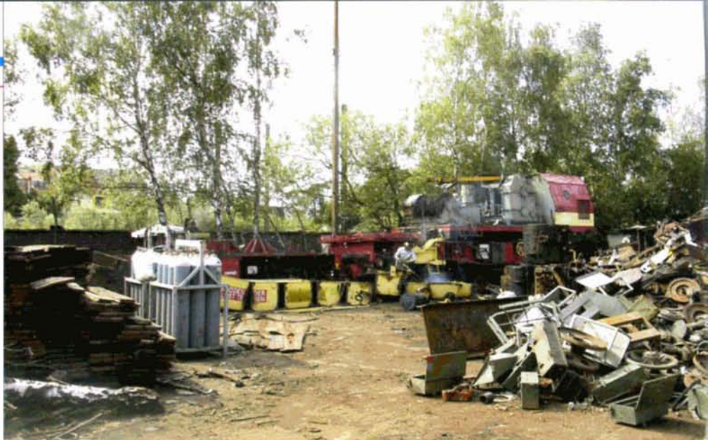
PHOTO 99-37 Chez Keizer à Courcelles, démolition de la grue de 55 t A310-8. Pierre HERBIET, 3 août 2010.
