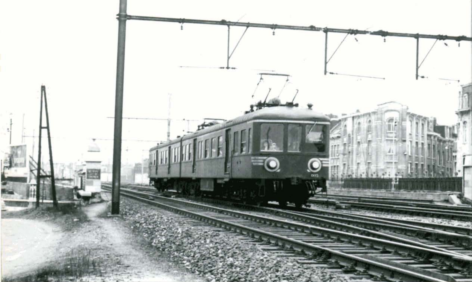
↑ La voiture BC (puis AB) de l'automotrice 228.005 avait la particularité d'avoir une banquette de deux places située à l'avant, à droite du poste de conduite; une place très prisée ! En mars 1964, elle assure un omnibus Essen - Antwerpen-Centraal, photographié à l'entrée de la gare d'Antwerpen-Schijnpoort. Daniel THIELEMANS.
