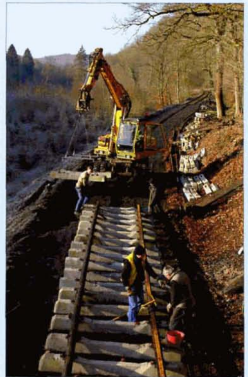
Deux vues du chantier de la courbe des Livottes. Les 130 premiers mètres ont été remplacés en une seule journée. PFT-CFB.
