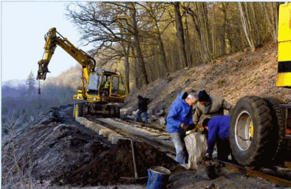
Deux vues du chantier de la courbe des Livottes. Les 130 premiers mètres ont été remplacés en une seule journée. PFT-CFB.
