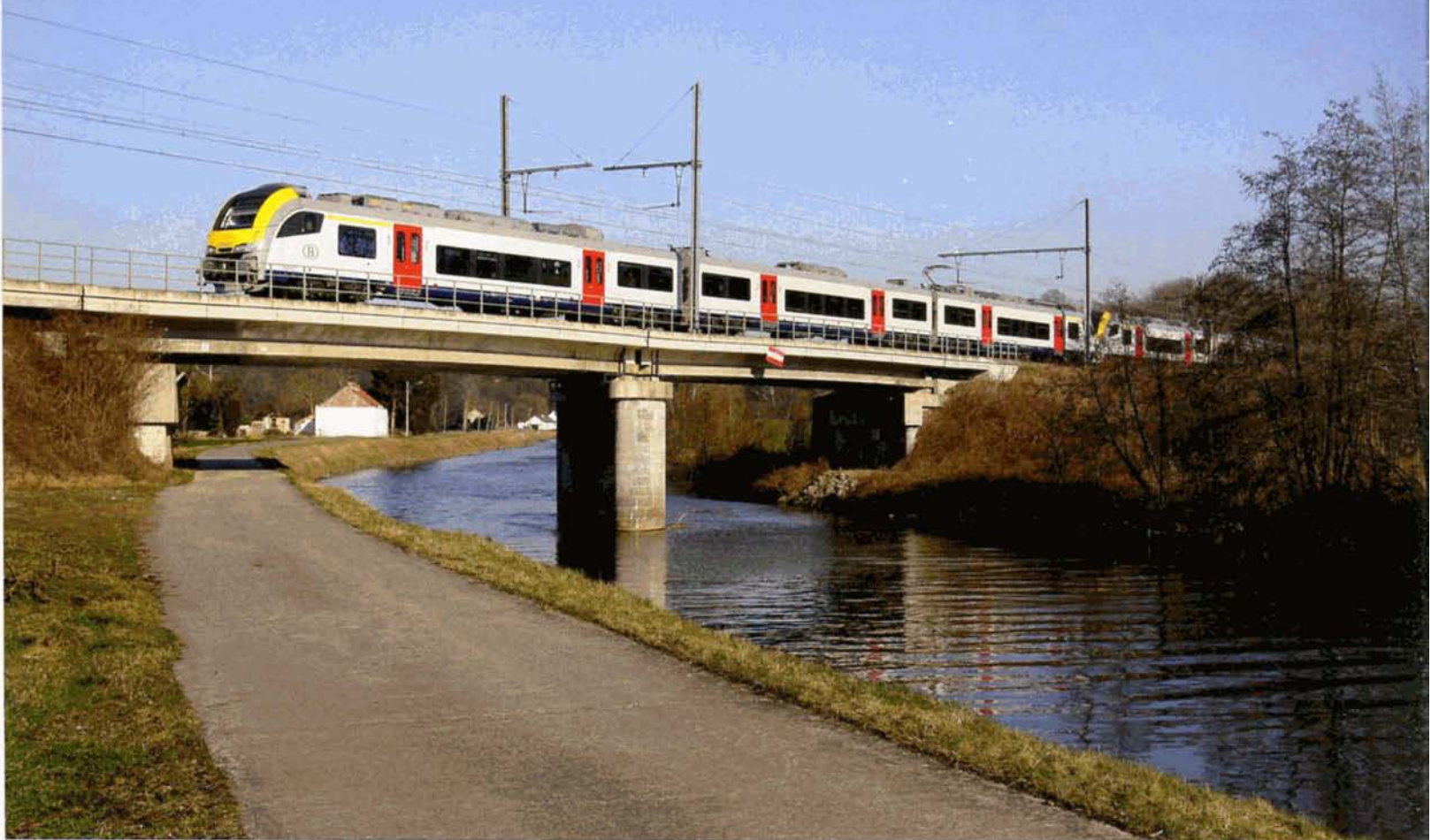
↑ PHOTO 108-28 Le 2 février 2012, le train L 4761 Charleroi-Sud - Erquelinnes, assuré par les automotrices Desiro 08001 et 08002, franchit la Sambre peu avant l'arrivée à Fontaine-Valmont, à hauteur de la rue Pré du Sart à Sars-la-Buissière (commune de Lobbes). Christian VANHECK.
