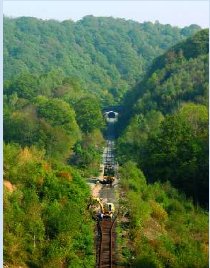
Een zicht op de vernieuwingswerken van het spoor richting Purnode. Op de achtergrond de tunnel naar Dorinne-Durnal met het vernieuwde spoor. Vooraan wordt de oude spoor uitgebroken. Centraal in beeld de motorwagen ES 102. Christian AUQUIERE, 15 oktober 2006.
