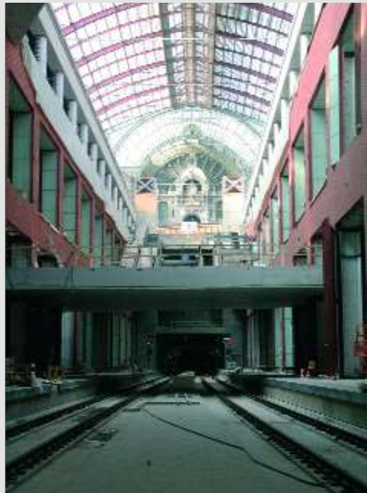
FOTO 76-37 ← FOTO 76-38 ↑ Twee foto's van het niveau -2 van het nieuwe station Antwerpen-Centraal. Boven : ter hoogte van de perrons, gezien richting noord. De vier niveaus zijn duidelijk zichtbaar : +1 (huidig station), 0 (commerciële ruimtes), -1 (4 vier nieuwe kopsporen) en -2 (tunnel). Links : inrit van het station, komende vanuit het noorden. In de tunnel zijn de sporen gelegd op een betonnen plaat, dus zonder ballast. Walter PINET.
