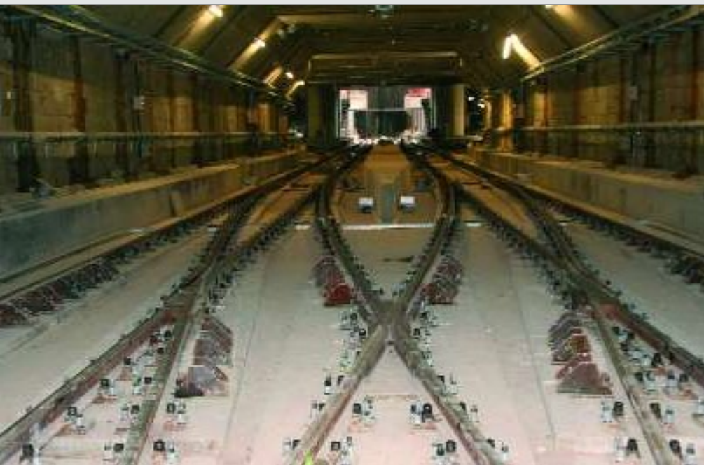
FOTO 76-37 ← FOTO 76-38 ↑ Twee foto's van het niveau -2 van het nieuwe station Antwerpen-Centraal. Boven : ter hoogte van de perrons, gezien richting noord. De vier niveaus zijn duidelijk zichtbaar : +1 (huidig station), 0 (commerciële ruimtes), -1 (4 vier nieuwe kopsporen) en -2 (tunnel). Links : inrit van het station, komende vanuit het noorden. In de tunnel zijn de sporen gelegd op een betonnen plaat, dus zonder ballast. Walter PINET.
