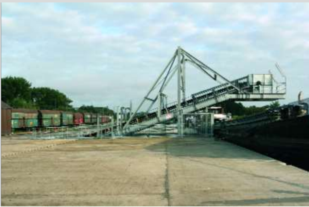
De nieuwe aansluiting te Clabecq: een ballastrein wordt gelost. De boot onmiddellijk geladen door middel van een transportband. 25 augustus 2008. Jean-Luc VANDERHAEGEN.
