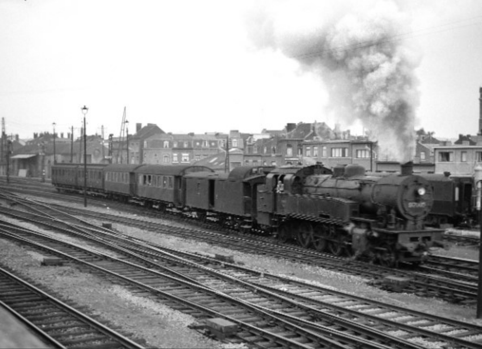
FOTO BD-289 Begin augustus 1953 verlaat een "Train-Trottinette" het station van Liège-Guillemins, gesleept door de 97.005. De trein is samengesteld uit achtereenvolgens een GCI-pakwagen, een T-rijtuigenstel en twee andere Pruisische rijtuigen van een totaal verschillend type. De twee T-rijtuigen zijn van Beierse afkomst en zijn geschilderd in twee tinten groen. Bruno DEDONCKER, verzameling TSP ©
