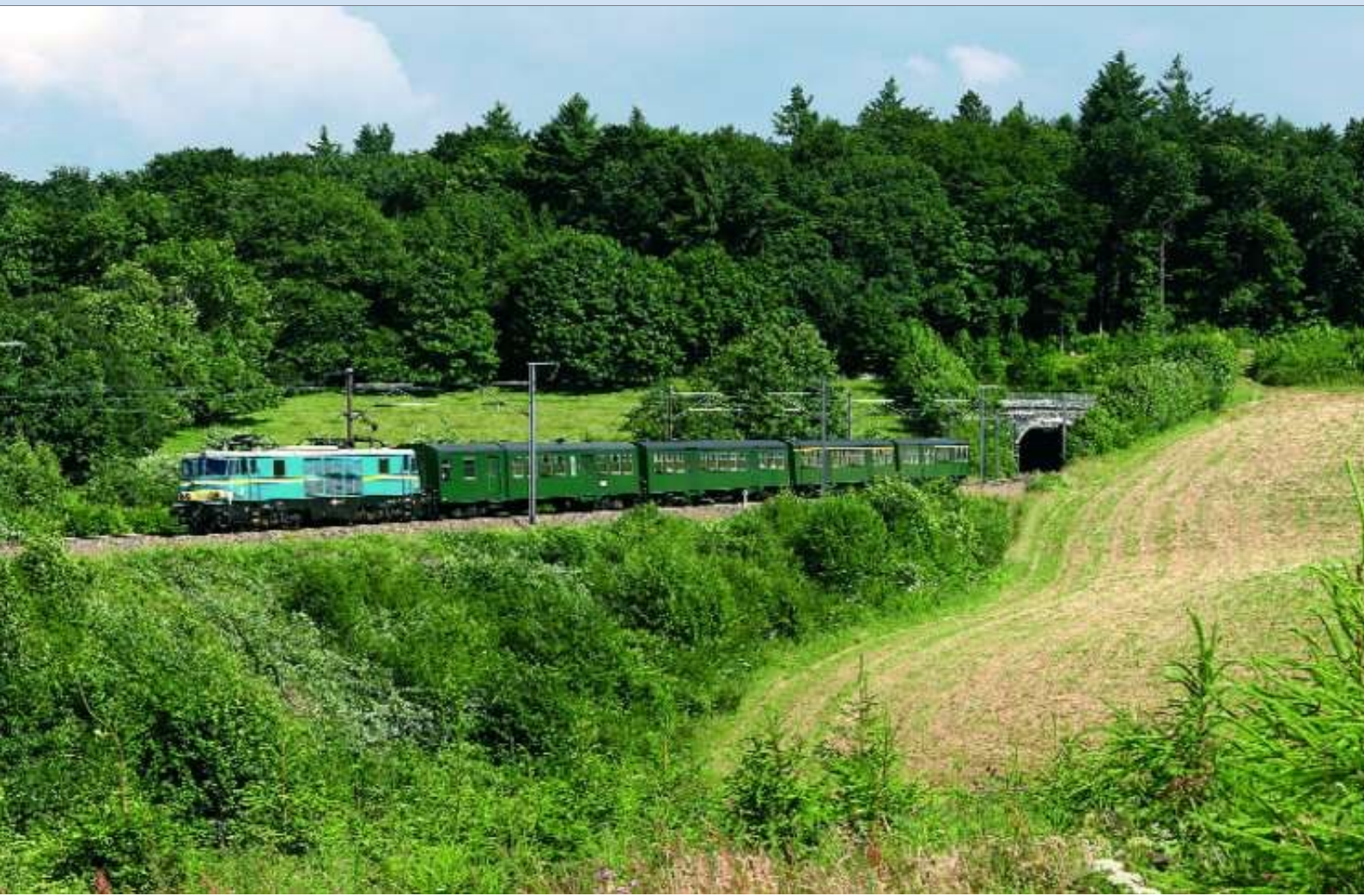
FOTO 87-10 De 1501 verlaat de tunnel van Vonêche.
