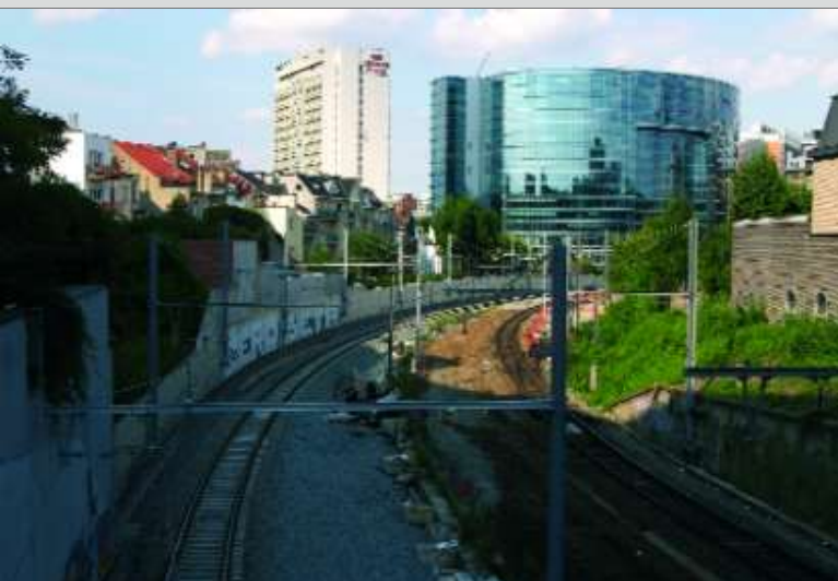
Op deze foto, genomen vanaf de Belliardstraat richting Brussel-Schuman, is duidelijk te zien dat het spoor naar Brussel van lijn 161 naar links verplaatst werd. Het spoor naar Ottignies zal dezelfde verplaatsing ondergaan, om rechts plaats te maken voor twee sporen van lijn 161A naar de tunnel Schuman-Josaphat. Brussel-Luxemburg, 14 juli 2008
