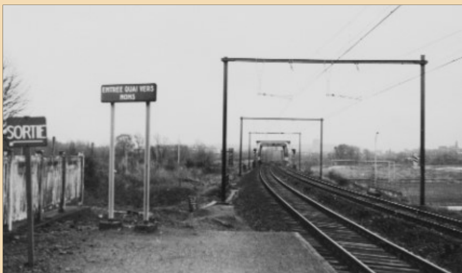
Het uiteinde van het perron van de stopplaats Maisières, richting Mons, bevond zich nabij de brug over het kanaal. DIEU, 15 november 1973.
