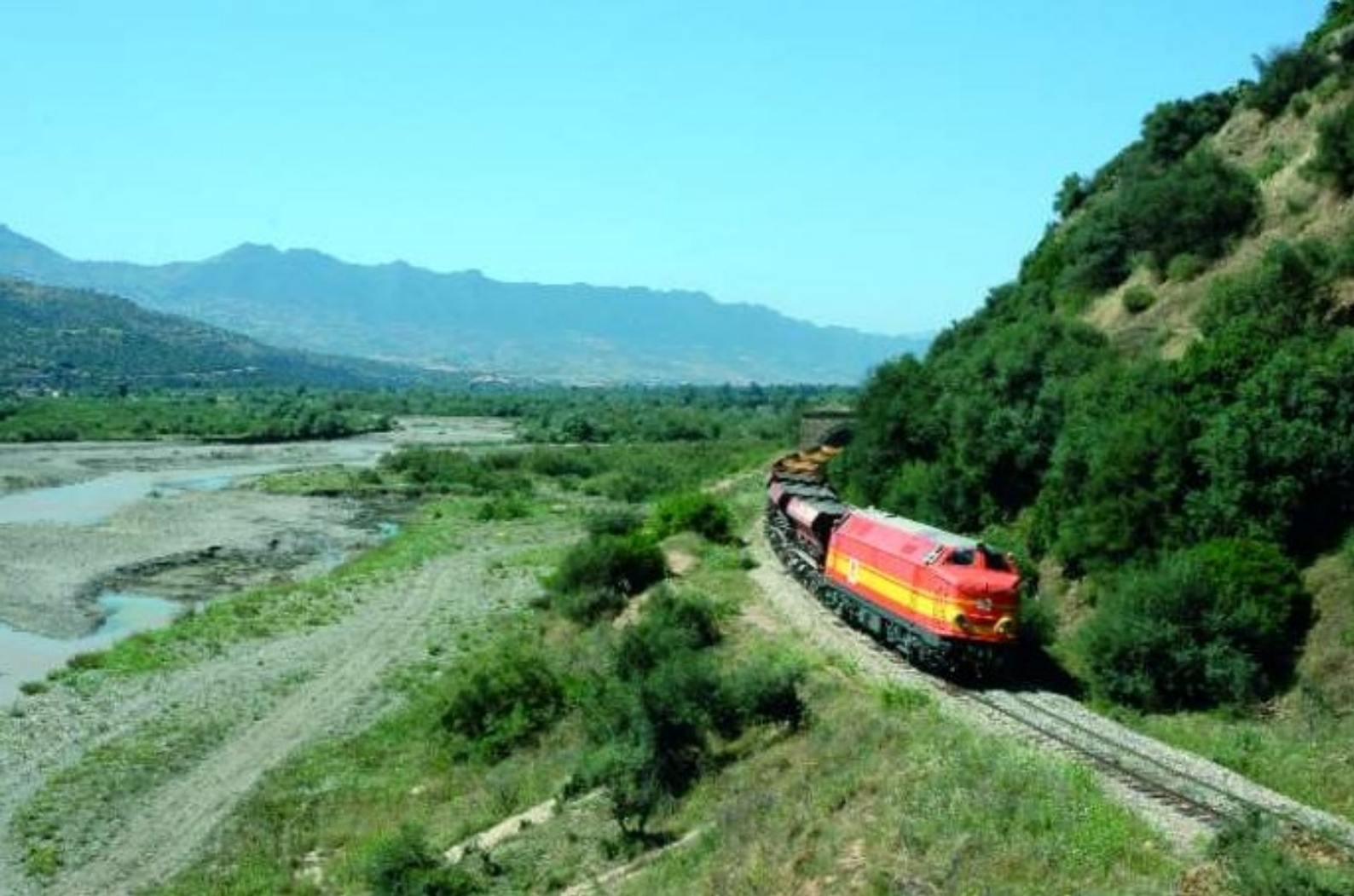
FOTO 87-95 De 5146 heeft een tunnel verlaten en rijdt nu op de oevers van de Oued Sahel.
