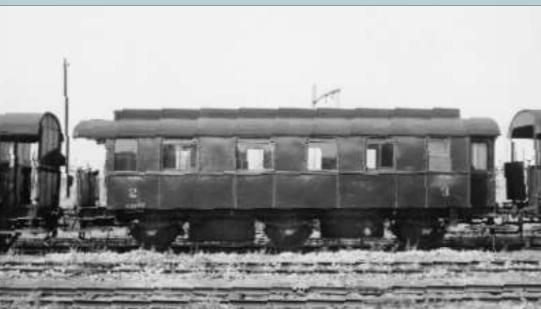
BC-rijtuig 83.682 (linker foto) - van Pruisische herkomst - en C-rijtuig 83.482 (rechter foto) - afkomstig uit Beieren - werden te Schaarbeek gefotografeerd in augustus 1951. Elk van beide rijtuigen is in feite een gehalveerd T-rijtuigenstel dat geschrapt werd. Later zullen ze samen gebruikt worden om het nieuwe rijtuigenstel 83.482 + 83.682 te vormen. De twee rijtuigen zijn hier nog niet omgebouwd en dragen de uniforme donkergroene livrei. Na haar schrapping werd rijtuig 83.682 gebruikt voor de bouw van een autotransportwagen, die op 23 juni 1958 buitenrolde uit de CW van Gentbrugge en in nachttreinen zou worden opgenomen. Foto G. DESBARAX, verzameling Bruno DEDONCKER / TSP ©.
