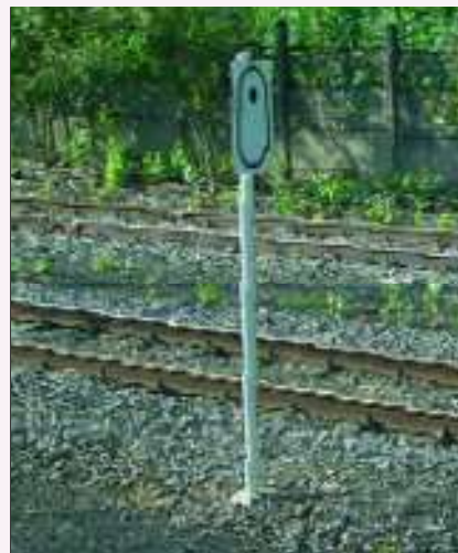
Een bord voor eerste vertrek is geplaatst in Marbehan aan het begin van de lokale lijn naar Croix-Rouge (lijn 155). Een beweging op deze lijn geschiedt vanaf dit bord in grote beweging in het regime normaalspoor.
