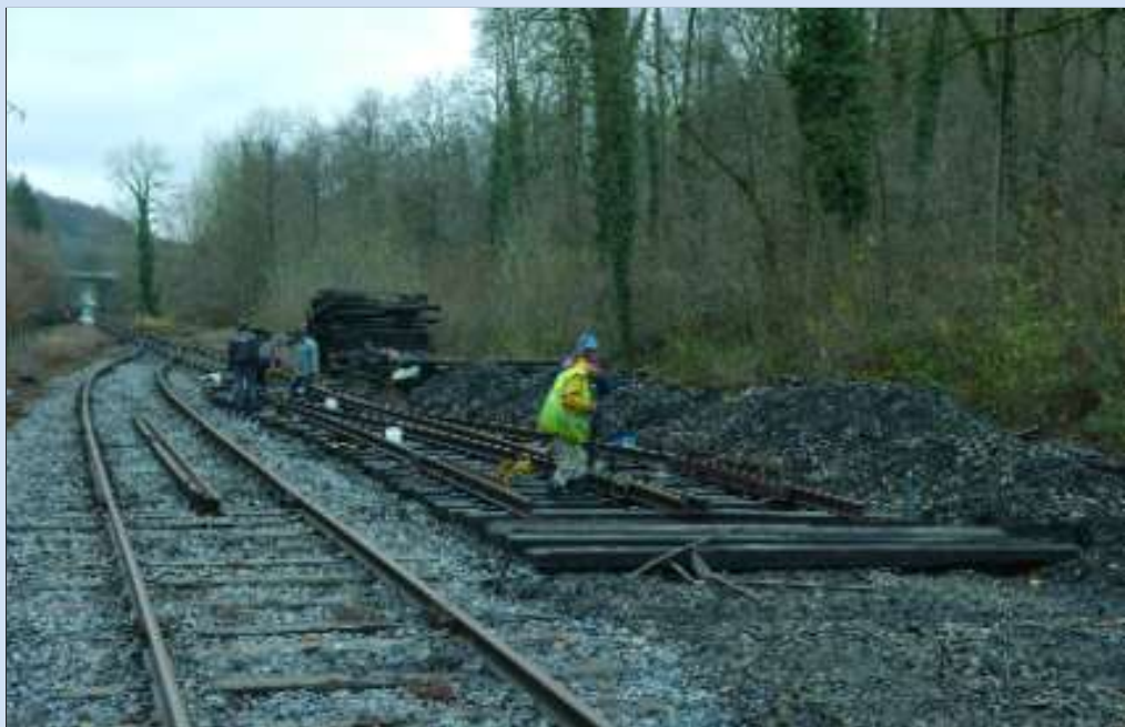
De ploeg van "le Chemin de Fer de Bocq" plaatst een nieuwe wissel in het station Dorinne-Durnal, waardoor een bijkomend afstelspoor werd gecreëerd. 16 november 2008. TSP.
