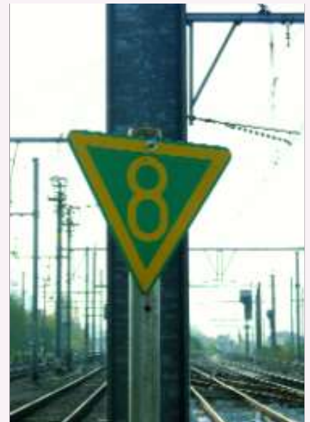
Een groen met geel omkaderd einde zonebord (AC-bord) is geplaatst op het einde van het station van Schaarbeek in de richting van Brussel-Noord. Een beweging die komt van een reisweg met een lagere toegelaten snelheid mag de snelheid herkennen tot deze weergegeven op het AC-bord.
