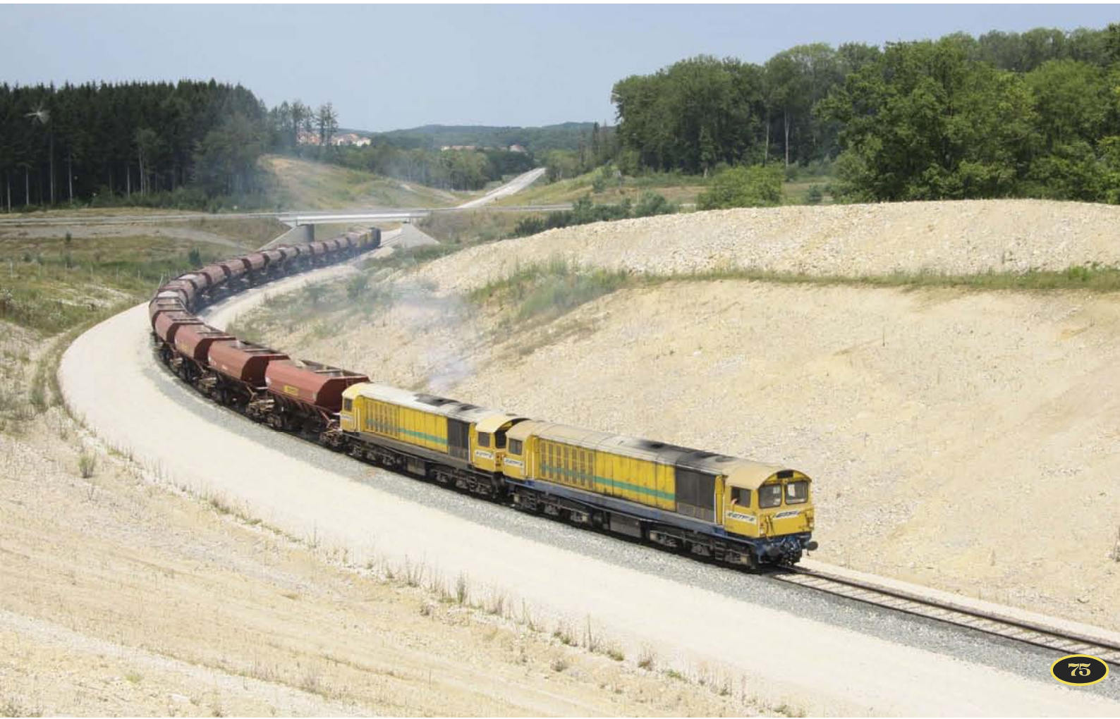
FOTO 100-94 ↑ - FOTO 100-95 ↓ De aanleg van de eerste fase (140 km) van de oostelijke tak van de LGV Rhin-Rhône die op termijn Dijon met Mulhouse moet verbinden (190 km) nadert zijn voltooiing. De lijn moet op 11 december 2011 in dienst komen. De werftreinen vertrekken vanuit de enige basis die werd aangelegd te Villersexel. Deze tijdelijke spoorverbinding tussen de HSL-werf en de basis is 4 km lang en zal na het beëindigen van de werken worden uitgebrouwen. De vrijgekomen ruimte zal dan worden gebruikt voor de aanleg van een ringweg rond Villersexel. Twee ondernemingen voeren het grootste gedeelte van de werken uit: ETF en TSO. Zij zetten elk 12 locomotieven Class 58 in, die gebouwd werden door Brel tussen 1983 en 1987 voor British Rail. De beide foto's, gemaakt in de buurt van Rougemont, tonen twee ballasttreinen die gesleept worden door vier Class 58 van ETF (twee vooraan en twee achteraan). Pierre HERBIET.
