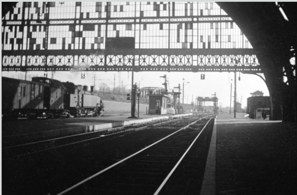
FOTO BD-102xx We zijn hier onder de stationskap van het tweede Mechelse station in 1948. De kap overspande 5 sporen en was 110 m lang, 42 m breed en 30 m hoog. Een reizigerstrein wacht op het vertrek met aan kop een locomotief type 94 met asindeling 2'C2'. Het is de 94.006, ex-9486 NMBS, ex-386 Nord-Belge – Cockerill 2783/1911). Zij maakte deel uit van de reeks 381 tot 386 "Gros revolver". Sinds 1947 was deze loc, evenals twee van haar zusters, toegewezen aan de stelplaats van Muizen waar ze in 1951 geschrapt werden. Aan de uitgang van het station zien we de ophaalbrug over het kanaal van Leuven. Foto G. SAELENS, verzameling B. DEDONCKER / TSP.
