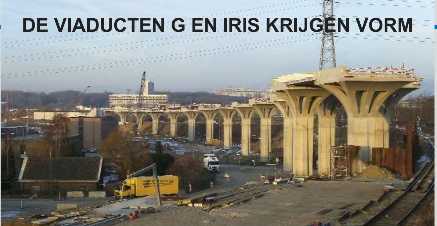
Zicht op viaduct Iris, vanaf lijn 26, in de richting van Brussel. De 967 m lange brug wordt gedragen door 34 pijlers. Haren, 5 januari 2011.
