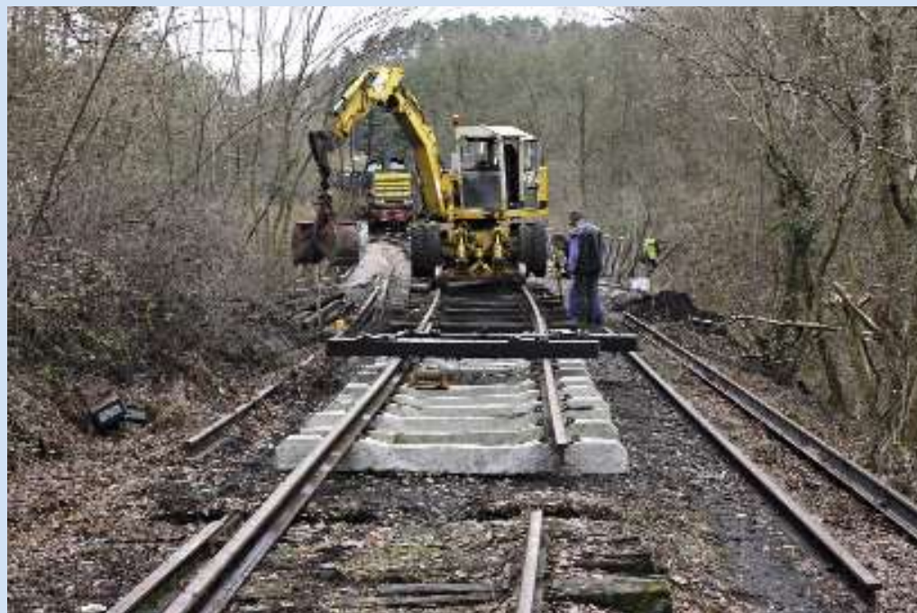
Na de aanleg van het spoor op de "Pont du mort" kon weer een verbinding met het oude spoor worden gemaakt. Hierdoor kan het materiaal afgeladen worden achter onze fotograaf Christian Auquière. TSP.
