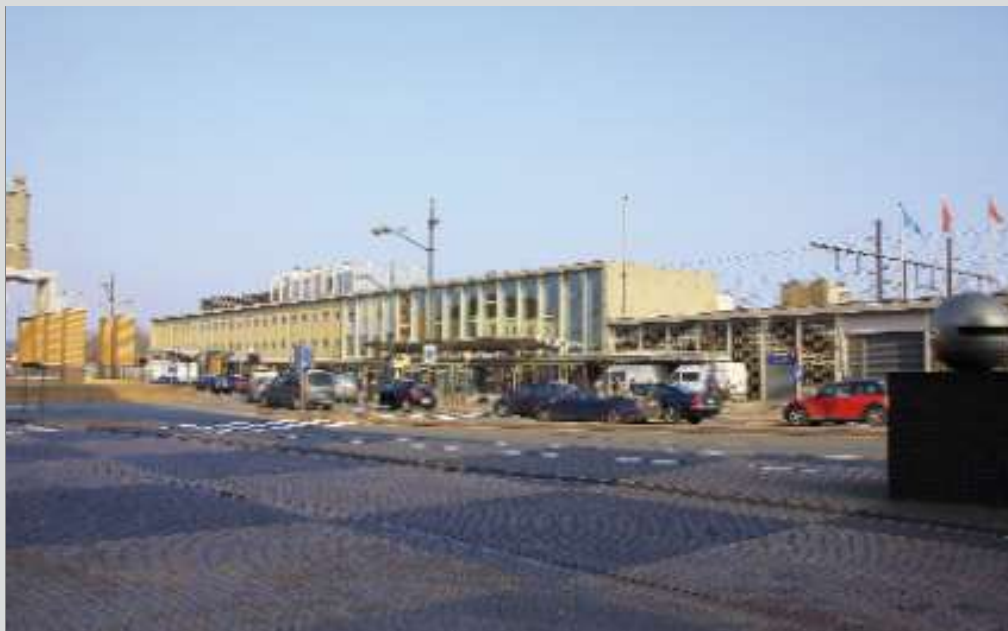
FOTO 102-XX Het stationsgebouw van Mechelen zoals wij het vandaag kennen. Het is niet echt een architecturaal hoogstandje...Links op de foto is de "Mijlpaal" zichtbaar. Pierre HERBIET, 4 maart 2011.
