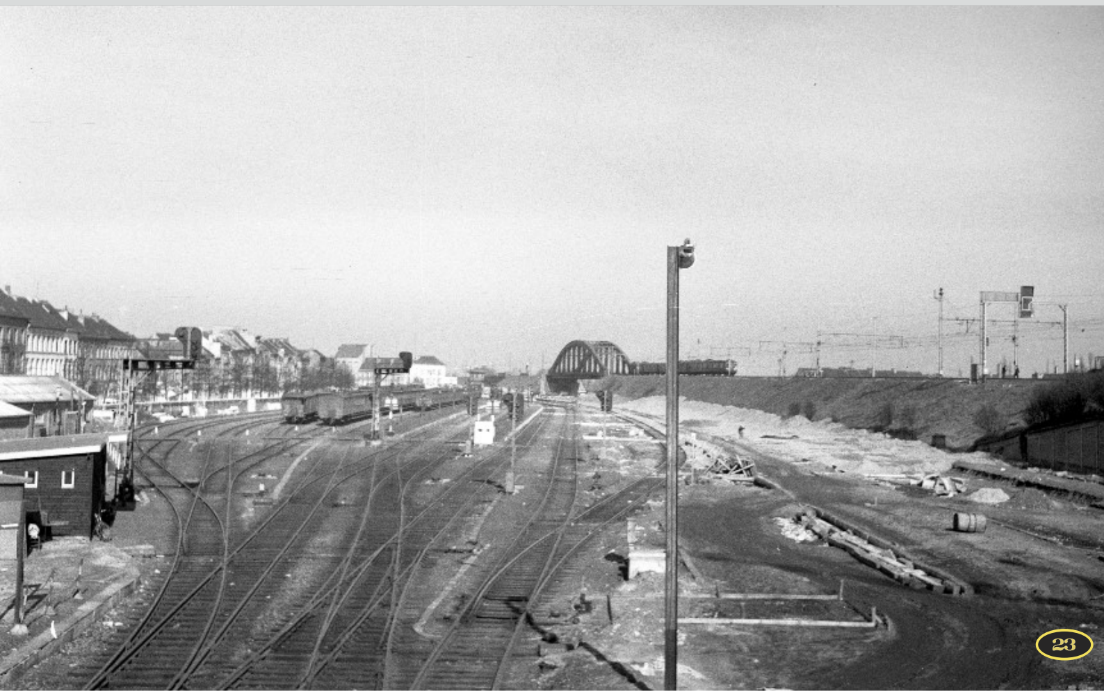
FOTO BD-102xx De grote werken voor de bouw van het derde station en de tegelijk uitgevoerde aanpassingen van de sporen, begonnen in 1952. In maart 1957 blijft er niets meer over van het oude station en zijn mooie kap. Heel de sporencomplex zal vernieuwd worden en alle sporen worden lichtjes verhoogd om makkelijk het kanaal van Leuven te overschrijden. Enkel de reeds verhoogde sporen van lijn 25, rechts op de foto, zullen op dezelfde plaats blijven liggen. Een elektrische trein uit Antwerpen rijdt over de Vierendeelbrug het station binnen. Foto: Bruno DEDONCKER, verzameling TSP.
