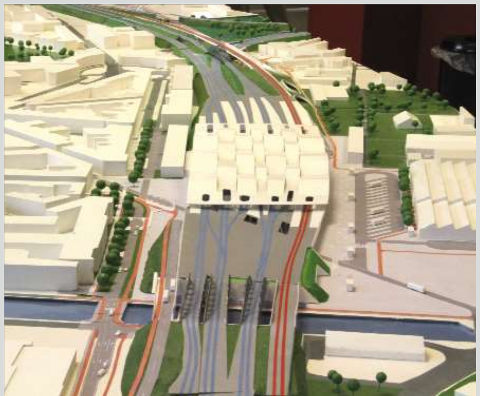
De maquette gezien in de richting Brussel. In het rood zien we de twee nieuw aan te leggen snelle sporen die, kijkend richting Brussel, links van lijn 25 voorzien zijn. In het midden zien we de huidige Vierendeelbrug die lijn 25 over de lijnen 53 naar Leuven en 53A naar Muizen leidt. We zien hier ook de nieuwe ringlaan die parallel met de nieuwe sporen over de terreinen van de Centrale Werkplaats zal aangelegd worden. Copyright TUC RAIL.
