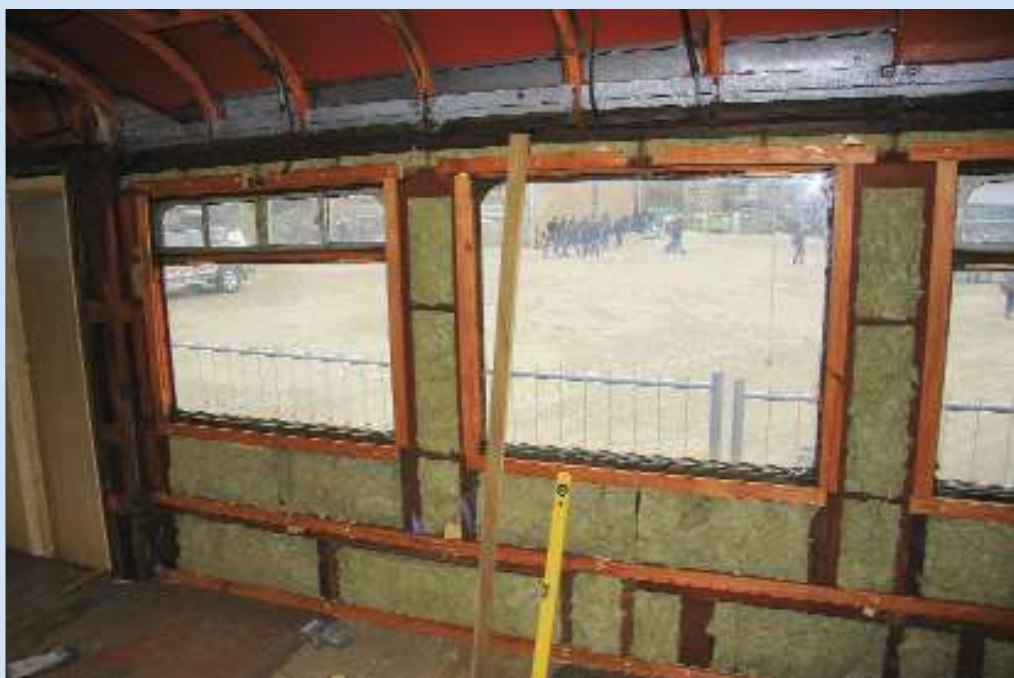
Twee foto's van de renovatie van de 551.26 door de studenten van de technische school TIO in Overpelt. De zijwanden en het plafond werden opnieuw geïsoleerd. TSP / Freddy DELARBRE.
