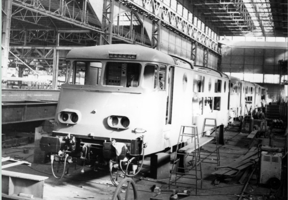
Een beeld van de opbouw van het type 126 van de tweede schijf (126.101 t/m 126.115) Robert BODDEWIJN.
