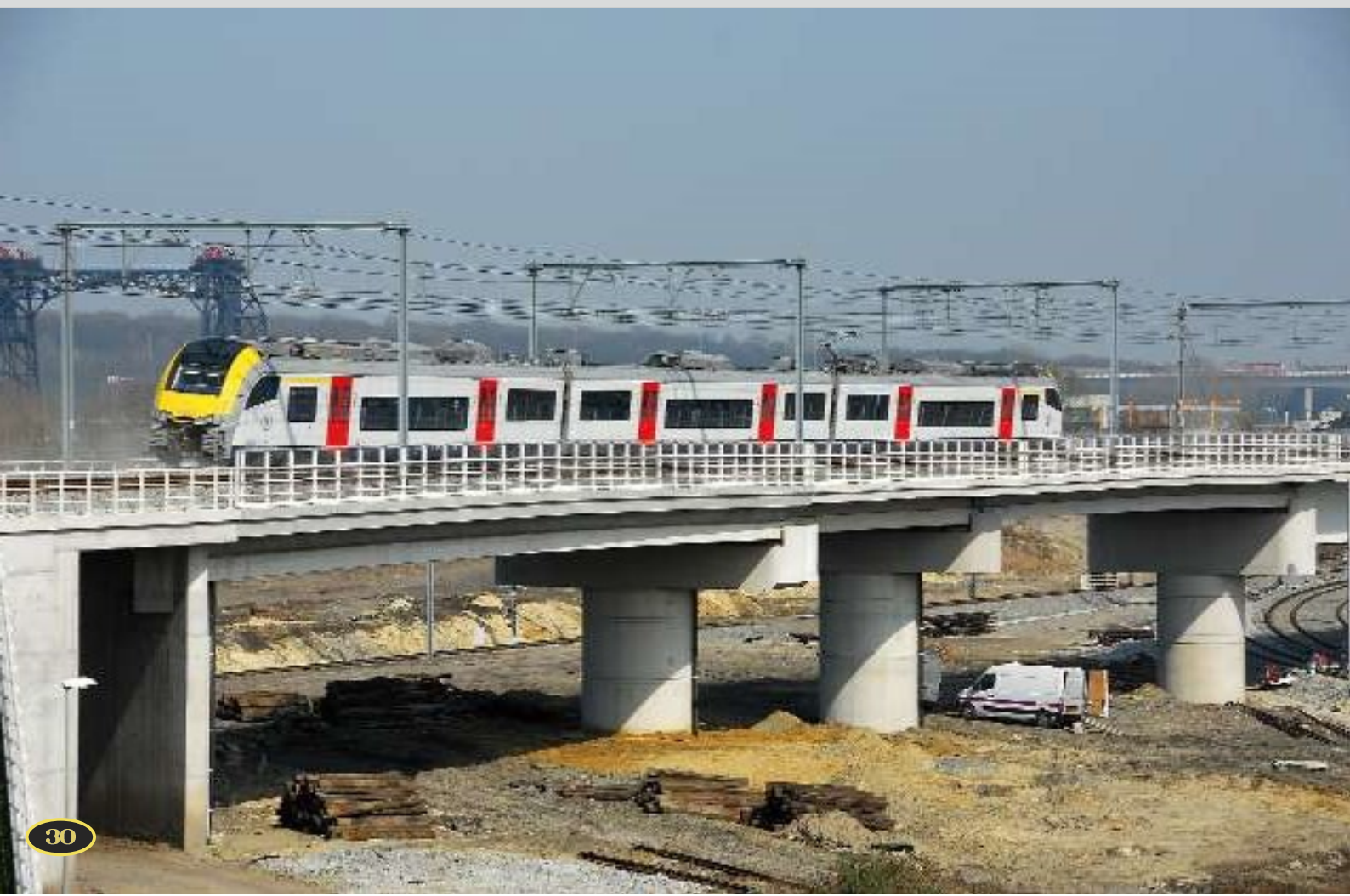
FOTO 109-39 Op 28 maart reed het Desiro-motorstel 08003 naar Mechelen. Het werd gefotografeerd op het viaduct over de bundel G van Schaarbeek Armand BEERLANDT.
