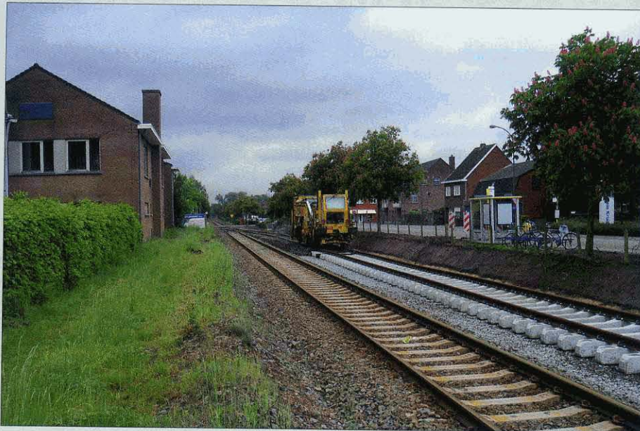
Deze drie foto's tonen ons de aanleg van het nieuwe uitwijkspoor voor het toekomstige station van Hamont. Deze werken werden uitgevoerd in mei en juni 2013. Dit station, gelegen op lijn 19 tussen Neerpelt en Weert (Nederland), wordt in december 2013 operationeel. Het zal bediend worden door sommige of alle treinen van de huidige IR-verbinding Neerpelt - Antwerpen-Centraal. Freddy DELARBRE, 29 mei 2013 (foto's 1 en 3), Andy ENGELEN, 3 juni 2013 (foto 2).
