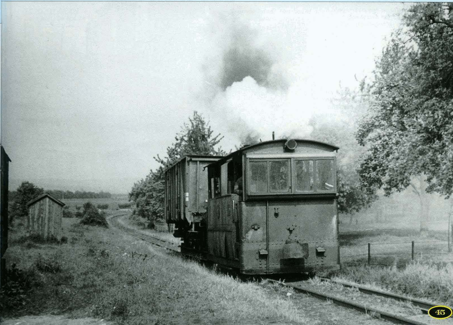
FOTO 117-62 ZW ↑ - FOTO 117-63 ZW ↓ Dalhem, 4 mei 1965. De 1075 sleept een op een rolwagen geplaatste lege stortwagen van Warsage naar de mijn. Foto's J. Benson, verzameling Maurice HENNEQUIN / TSP.
