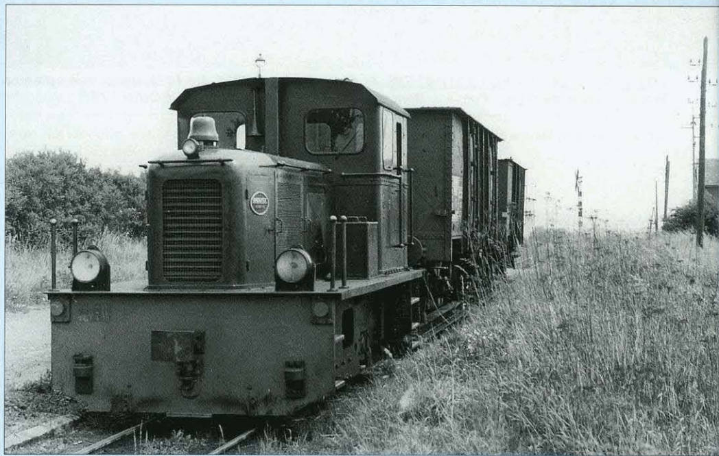
↑ Een goederentrein van de Charbonnage d' Argenteau naar Warsage zal weldra de tunnel van Dalhem inrijden. De locomotief werkt op vol vermogen. De trein bestaat uit drie wagens voor normaalspoor die op rolwagens werden geplaatst en een pakwagen. Auteur en datum onbekend. Verzameling HENNEQUIN / TSP.
