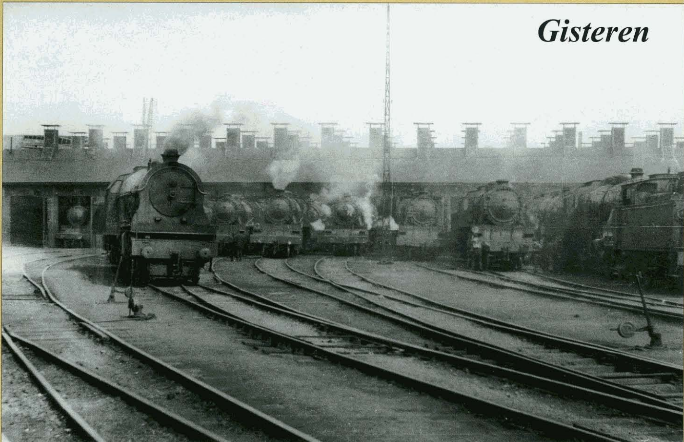
↑ De werkplaats van Arlon sloot de deuren op 15 december 1930 en alle activiteiten werden overgeheveld naar de nieuwe werkplaats Stockem. Deze foto dateert van 7 september 1922 en geeft een mooi overzicht van de locomotieven die wachten op hun volgende inzet. Het type 38 overheerste hier. Links is nog een type 36 zichtbaar, rechts een type 23. Foto: L. DERENS, verzameling Maurice HENNEQUIN / TSP.
