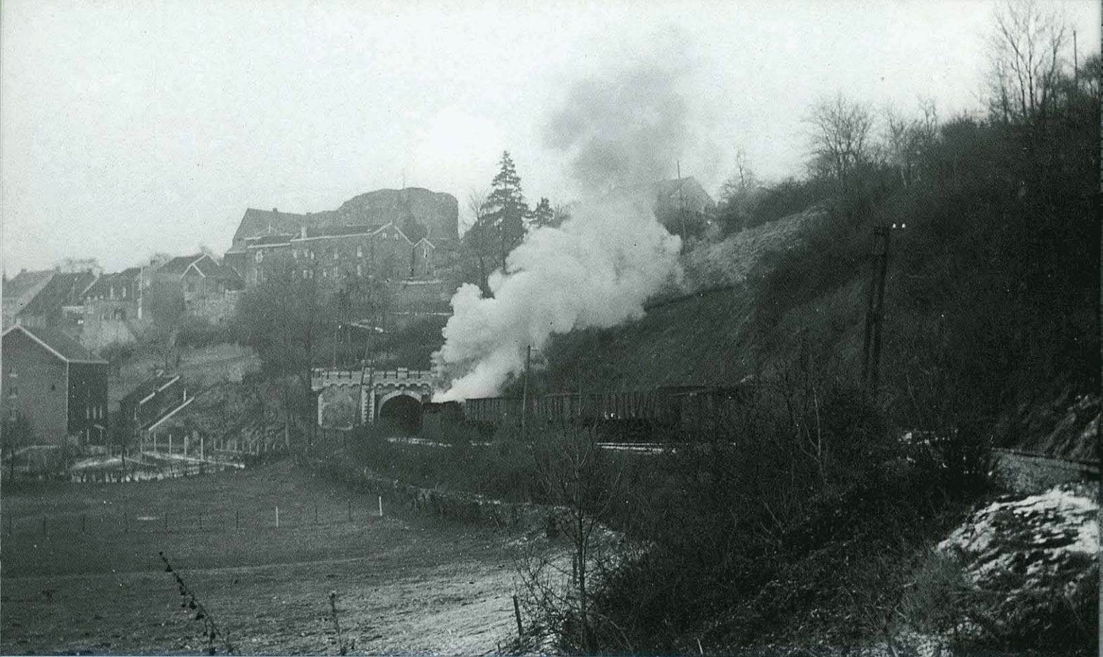
↑ Een goederentrein van de Charbonnage d' Argenteau naar Warsage zal weldra de tunnel van Dalhem inrijden. De locomotief werkt op vol vermogen. De trein bestaat uit drie wagens voor normaalspoor die op rolwagens werden geplaatst en een pakwagen. Auteur en datum onbekend. Verzameling HENNEQUIN / TSP.
